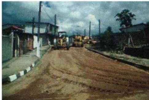
Fotografia 7 – Terraplanagem para pavimentação asfáltica .
