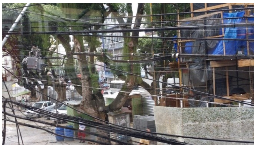
Figura 21 - Canteiro de obras da Praça do Relógio de São Pedro
