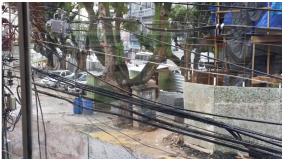
Figura 18 - Isolamento da Praça do Relógio de São Pedro –Início da reforma do calçamento
