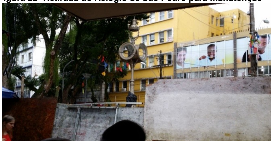
Figura 22- Retirada do Relógio de São Pedro para manutenção
