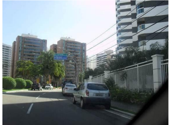
Figura 65 - Outros edifícios dentro do Alphaville Salvador, 2012.
