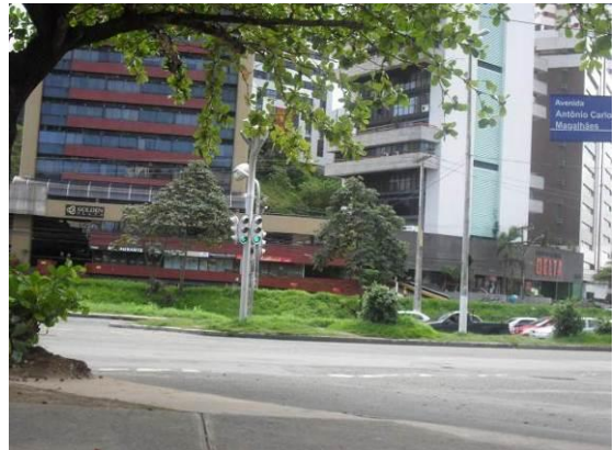
Figura 12 - Prédios empresariais na Av. ACM, 2012.
