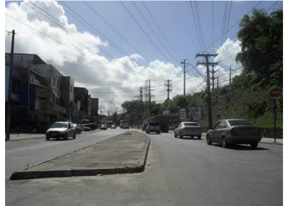
Figura 32 - Avenida São Marcos, 2012.
