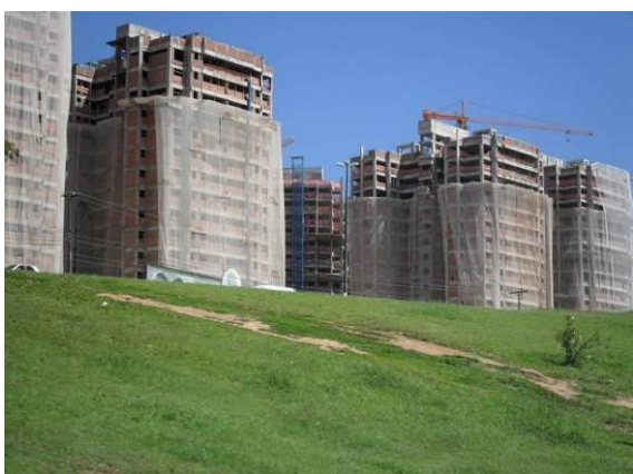
Figura 58 - Empreendimento Le Parc na Av. Paralela, 2011.
