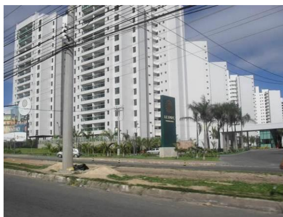
Figura 59 - Empreendimento Le Parc na Av. Paralela, 2012.
