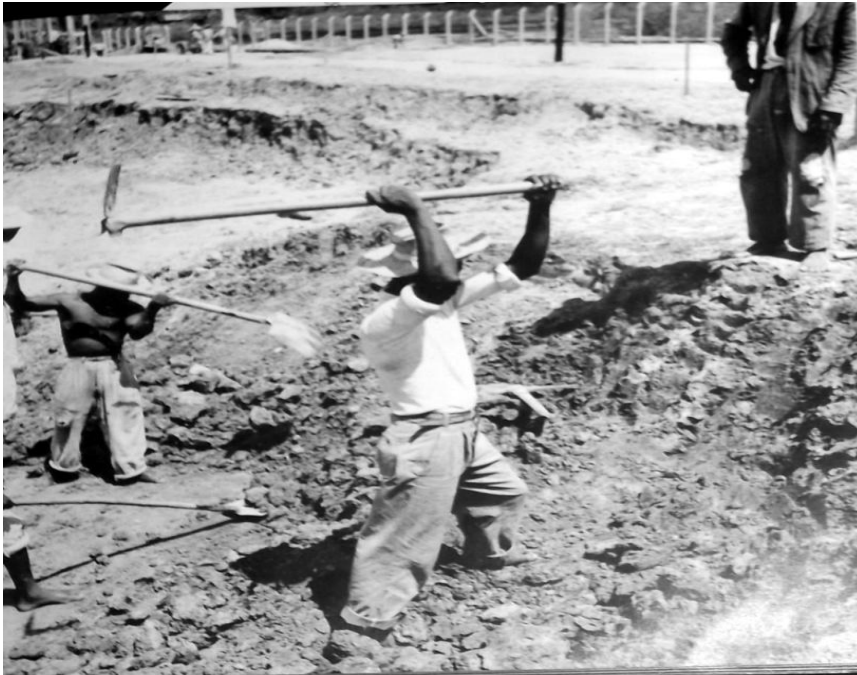
Figura 7 - Trabalhadores braçais na construção da RLAM – final dos anos 1940
