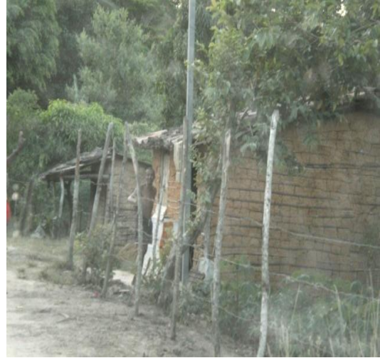
Figura 27- Casas de taipa, em rua sem calçamento e sem serviços de infra-estrutura em geral, sem água encanada e esgotamento sanitário, Porto de Brotas (Sede), 2010
