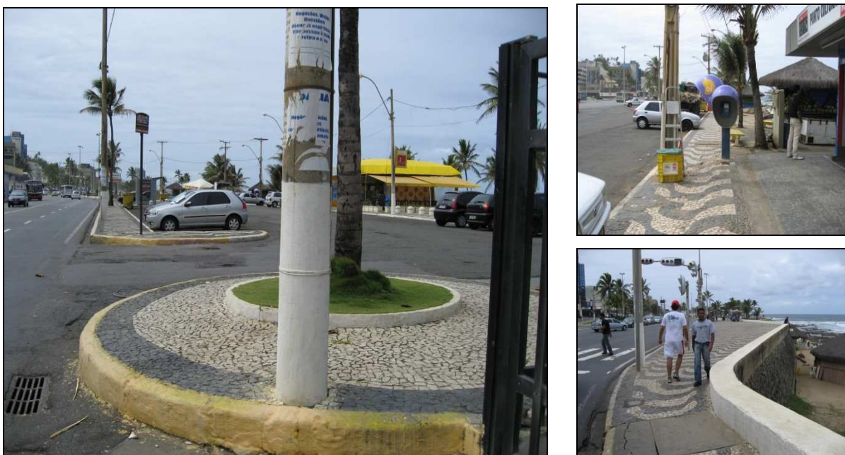
Figura 82 – Salvador: Ondina - Trecho da Avenida Oceânica, até a altura da Avenida Adhemar de Barros. Revestimento em pedra portuguesa, com detalhes
