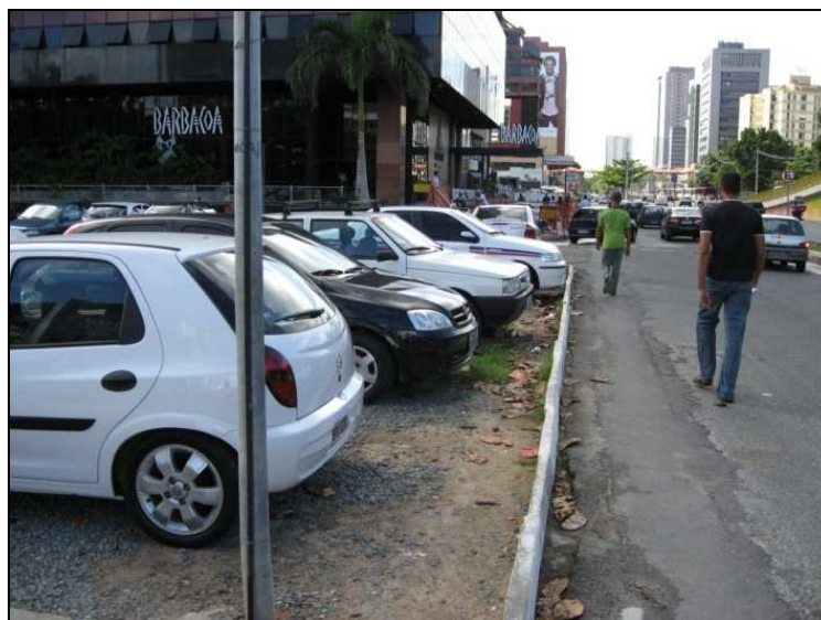
Figura 33 - Salvador: Avenida Tancredo Neves – Trecho sem calçada
