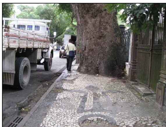
Figura 75 - Salvador: Corredor da Vitória – Detalhe3 do passeio local – Fotografia: Francisco Lacerda Brito, ago./2007.
