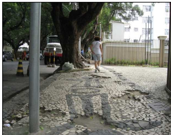
Figura 74 - Salvador: Corredor da Vitória – Detalhe2 do passeio local Fotografia: Francisco Lacerda Brito, ago./2007.
