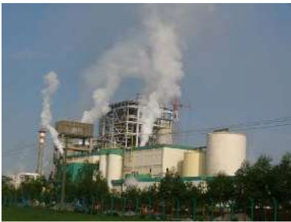
Figura 14 – Vista da planta em construção
