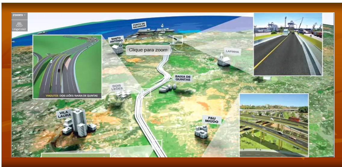
Figura 1 - Obras da Via Expressa Baía de Todos os Santos
