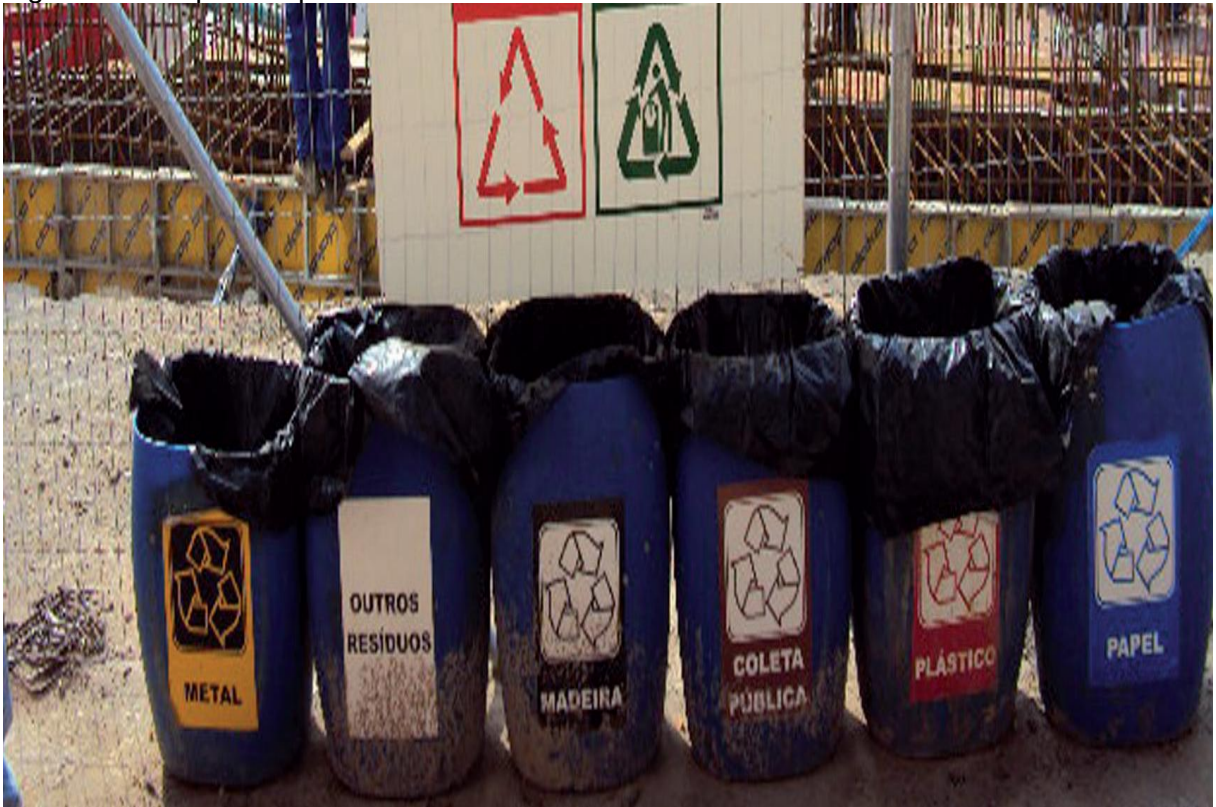
Figura 1 - Recipientes para coleta seletiva dentro da obra
