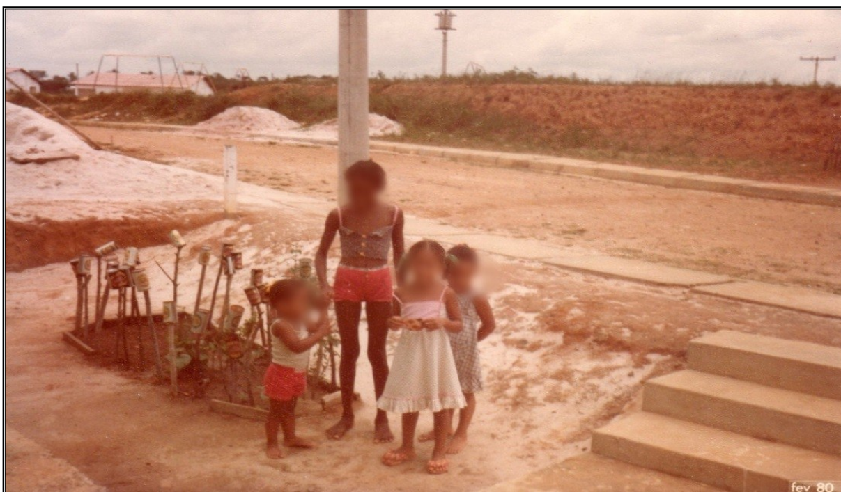
Figura 2 – Foto do espaço do Conjunto usado para construção do Colégio
