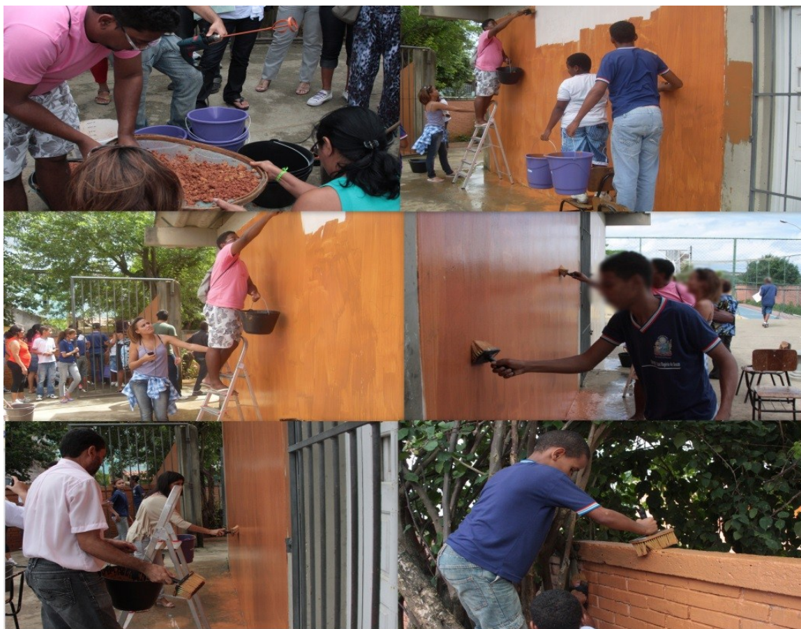
Figura 18 - Pintura com tinta de solo
