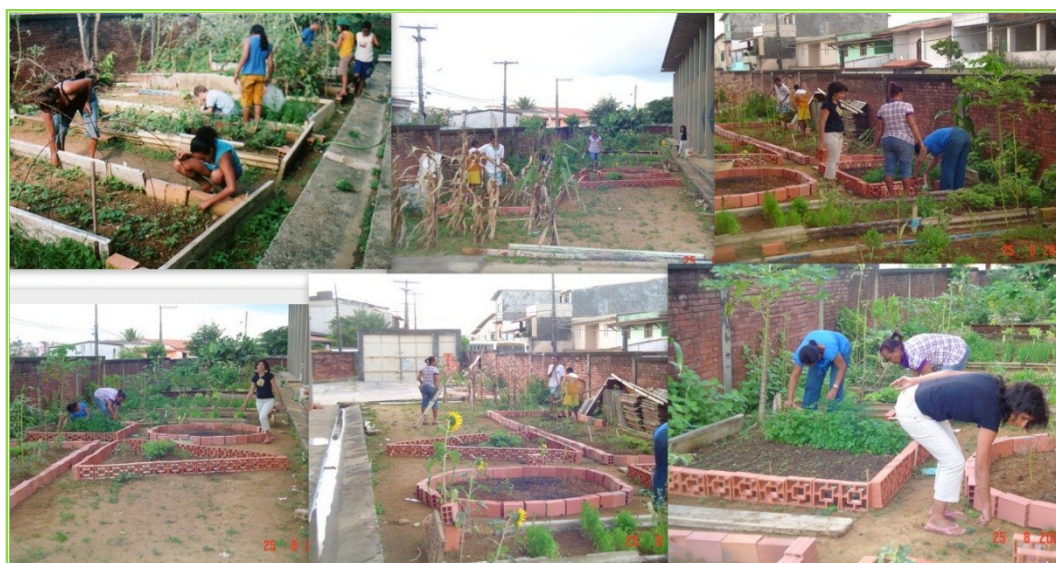
Figura 6 – Fase da construção das leiras
