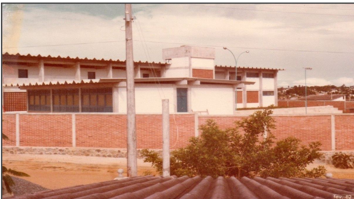
Figura 3 – Foto da conclusão da construção do Colégio
