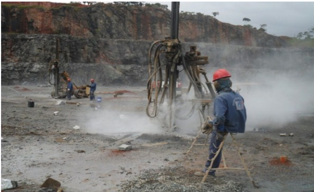
Figura 18 - Perfuração em diâmetro 3 ½” para posterior desmorte com explosivo
