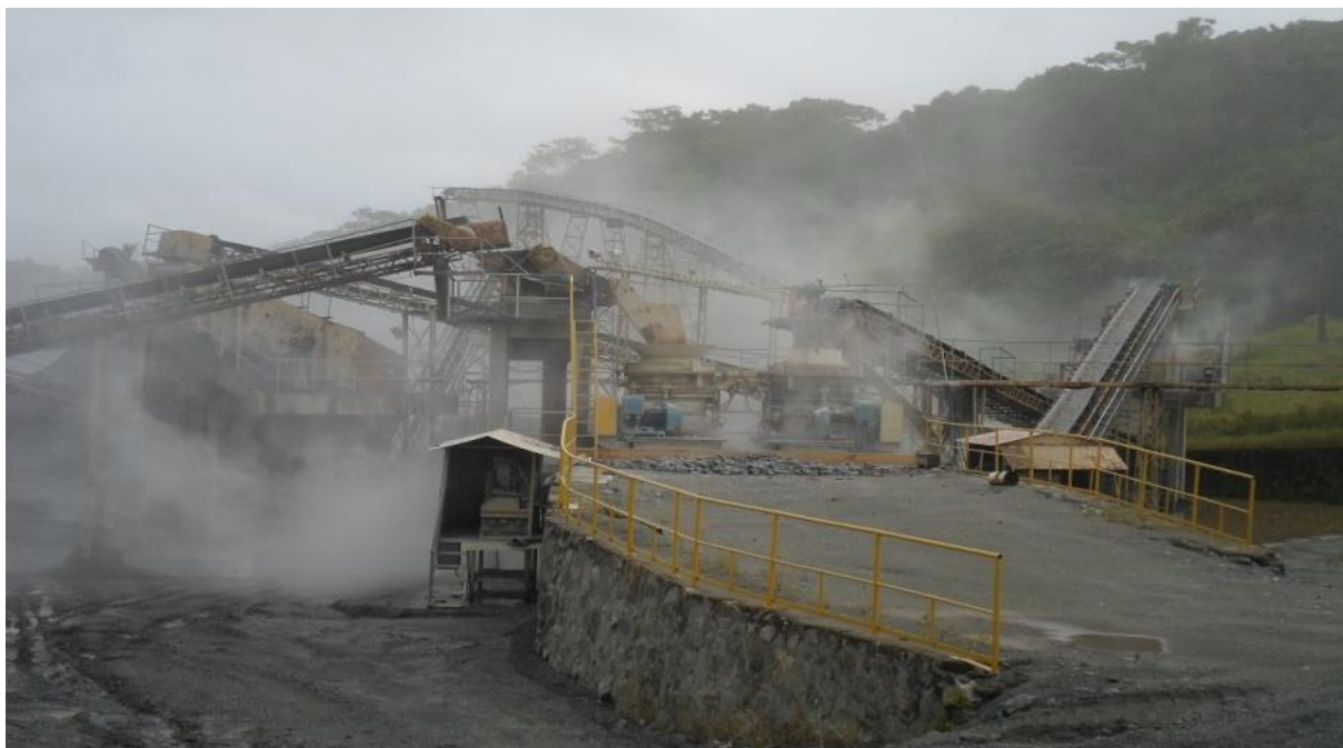
Figura 22 - Vista geral da unidade de beneficiamento (central de britagem)
