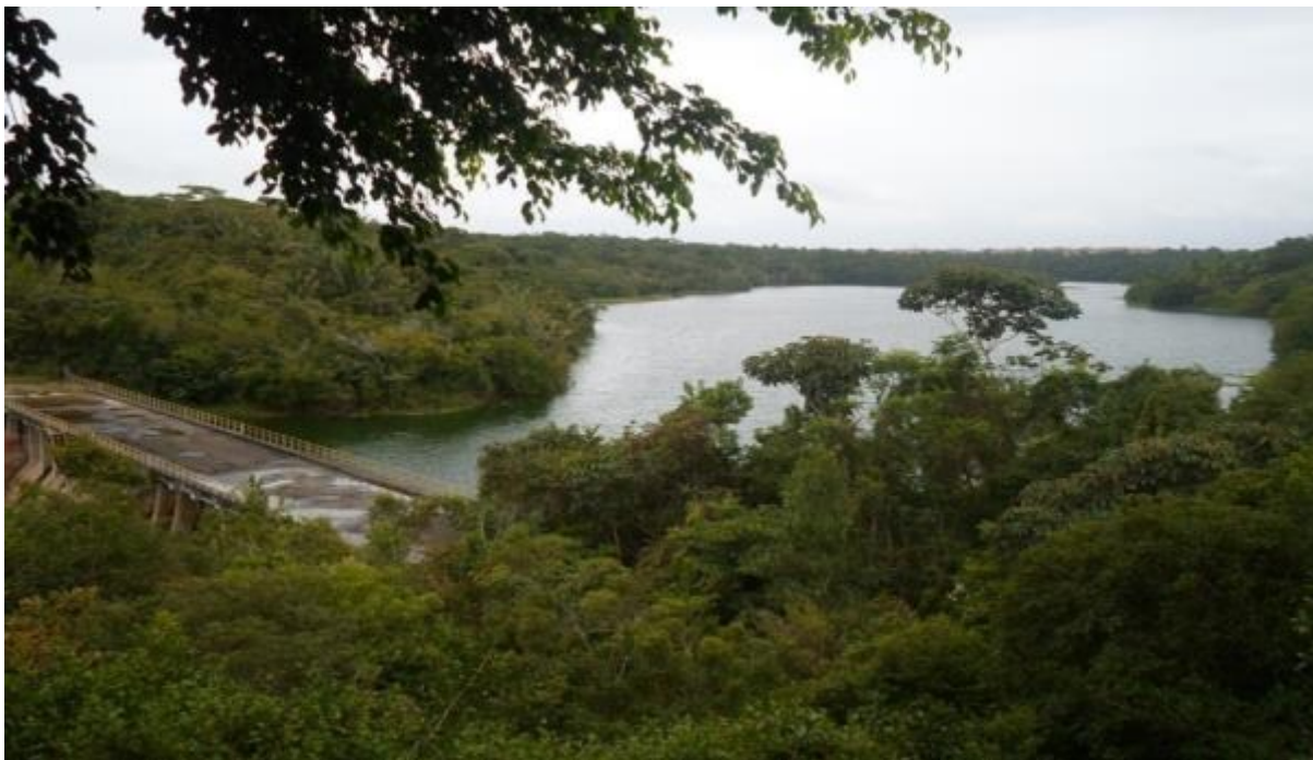
Figura 25 - Barragem Ipitanga II (Rio Ipitanga na área do empreendimento)
