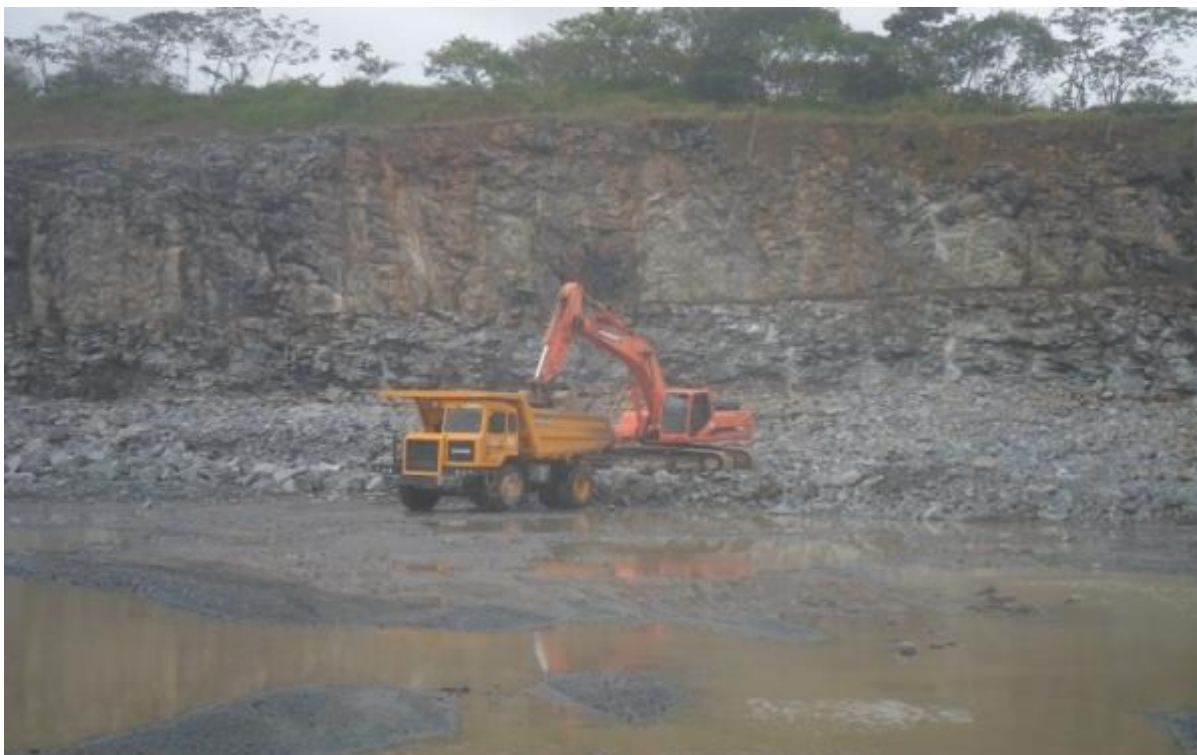
Figura 21 - Carregamento e transporte dos blocos de rocha após detonação
