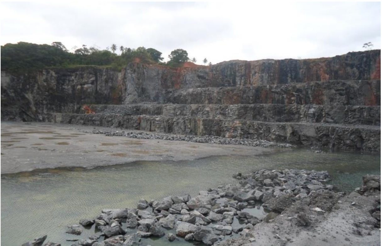
Figura 20 - Vista de blocos rochosos fragmentados por explosivos
