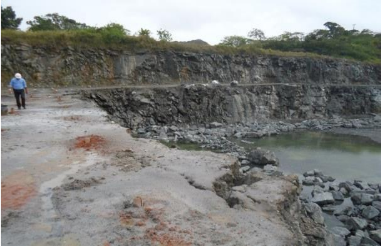
Figura 19 - Desmorte com explosivo. Blocos de rocha para carregamento
