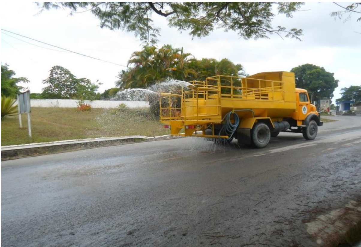
Figura 34 - Uso de caminhões-pipa para reduzir as poeiras
