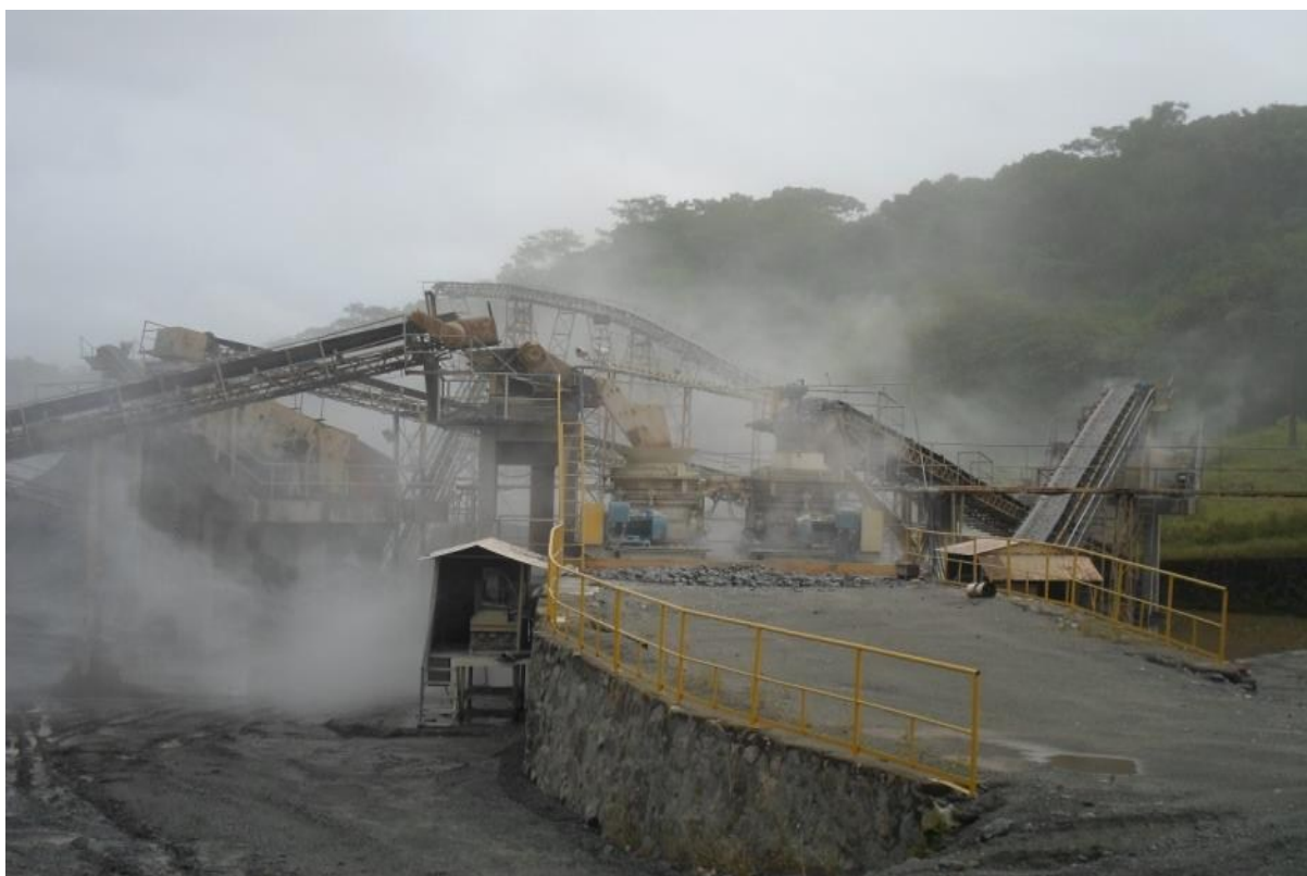
Figura 33 - Unidade de beneficiamento (britador) com geração de pó de rocha e poeira
