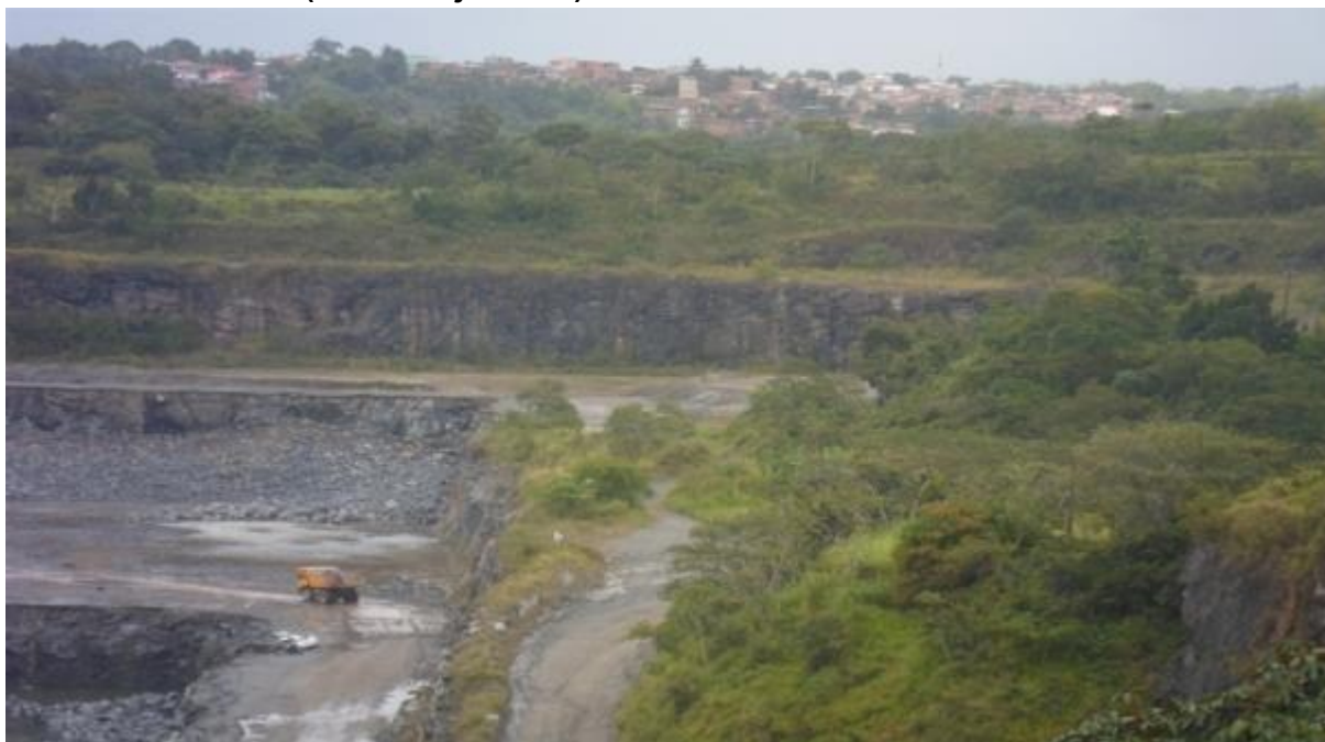
Figura 26 - Parte da área de lavra da pedra. Observar ao fundo o loteamento Santo Antônio (bairro Cajazeiras)
