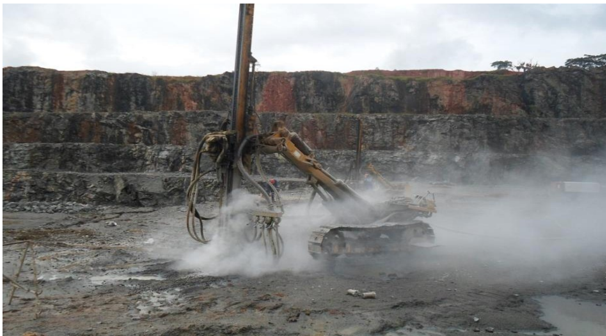
Figura 32 - Perfuratriz executando o furo com a geração de pó de rocha
