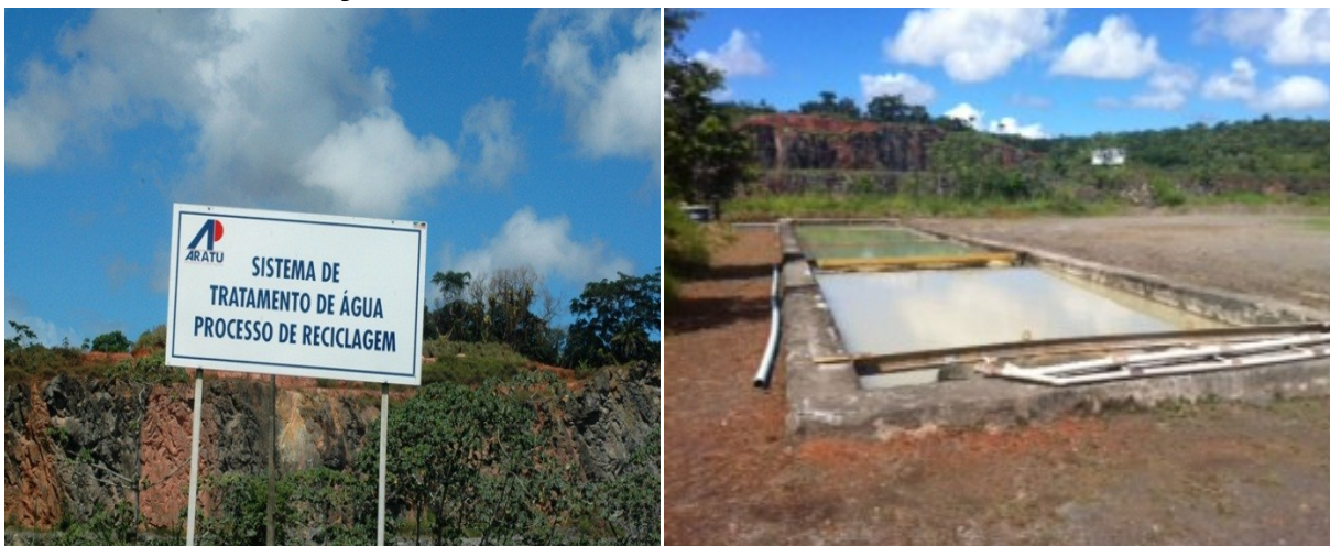
Figura 39 - Sistema de tratamento de água usada na britagem, com tanques de decantação
