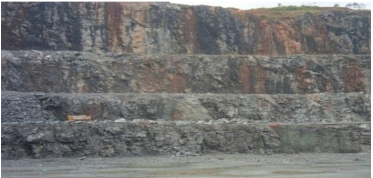
Figura 16 - Detalhe das bancadas a partir do piso (cota: -22m)
