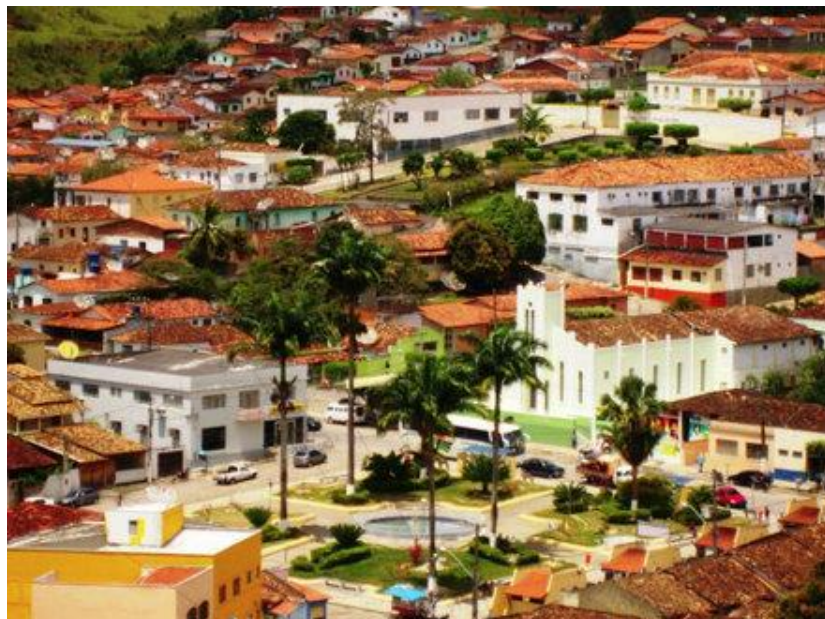
Figura 16: Vista Parcial de Nova Canaã Fonte: Portal Poções, 2014.
