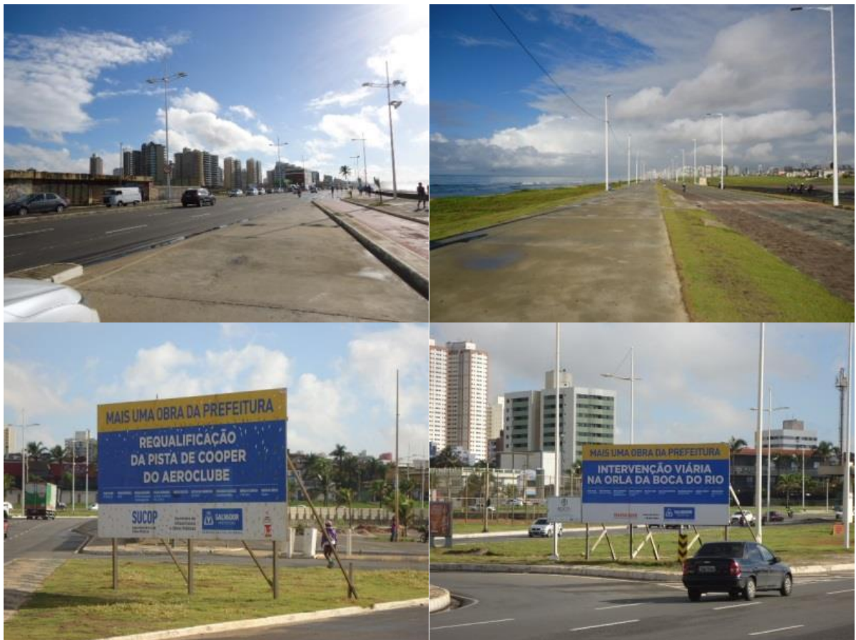
Figura 14 - Intervenções pública no entorno do bairro Boca do Rio
