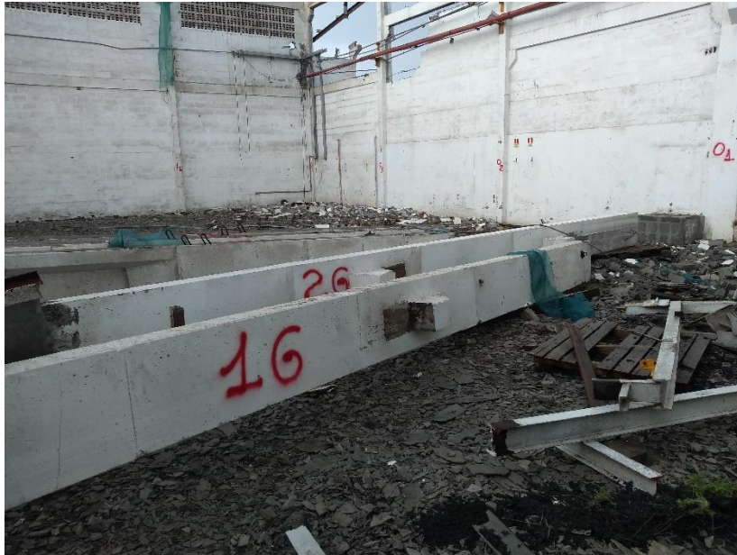
Figura 19 – Identificação das vigas
