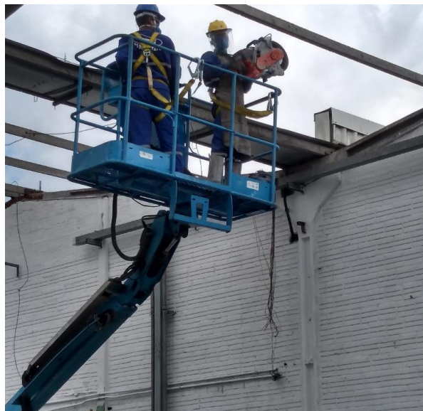
Figura 18 – Retirada das terças
