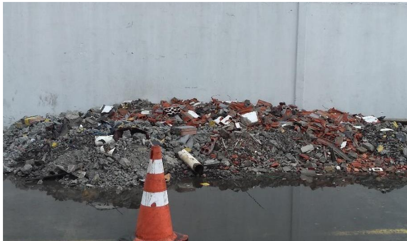
Figura 27 - Resíduos da retirada do piso
