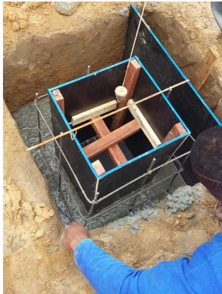
Figura 29 – Sapata para a remontagem do galpão
