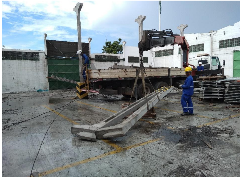
Figura 26 – Transferência de pilar para caminhão
