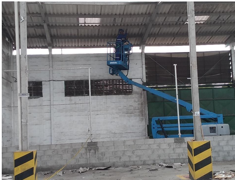
Figura 15 – Retirada das telhas
