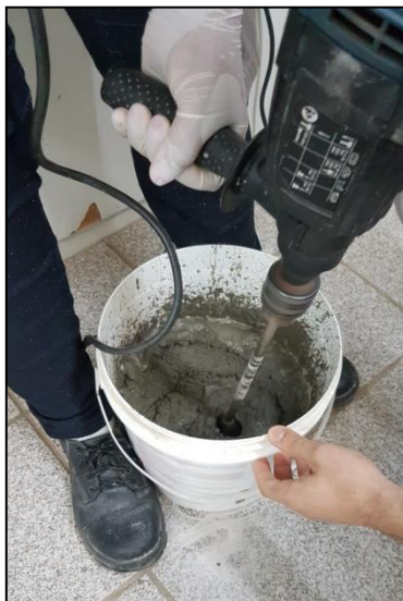
Figura 1 – Misturando a argamassa com misturador elétrico no recipiente cilíndrico.
