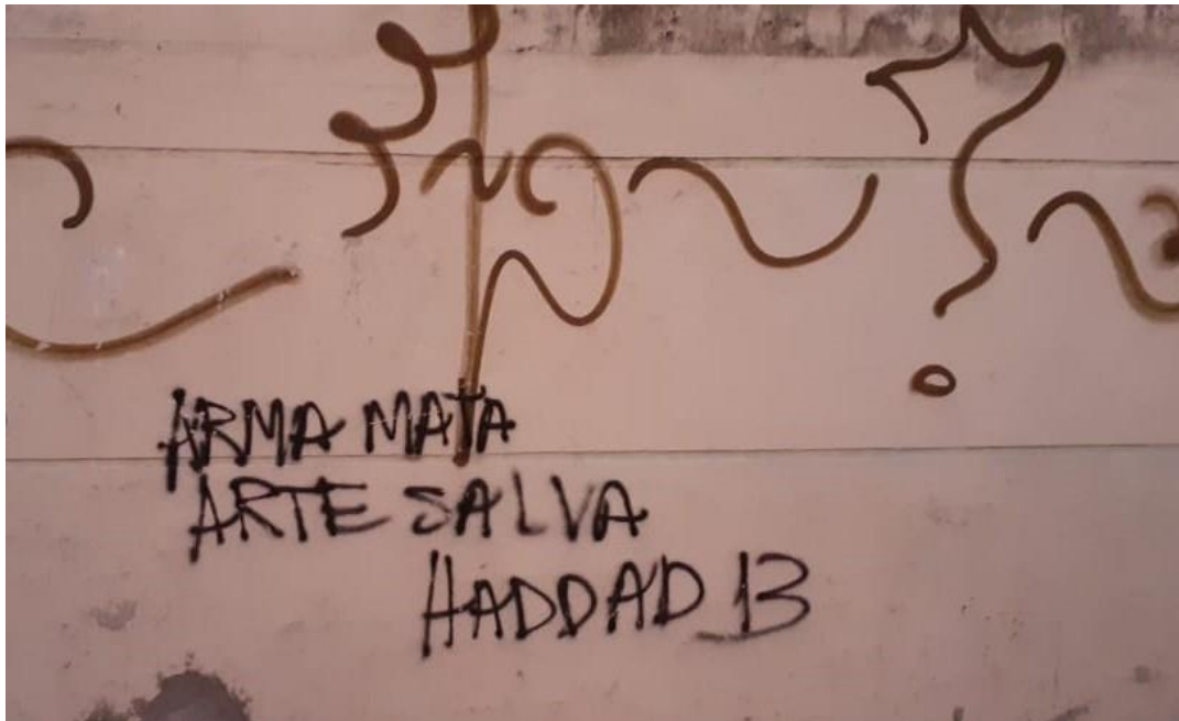
Murro no Edifício Avenida Dom João VI - Brotas
