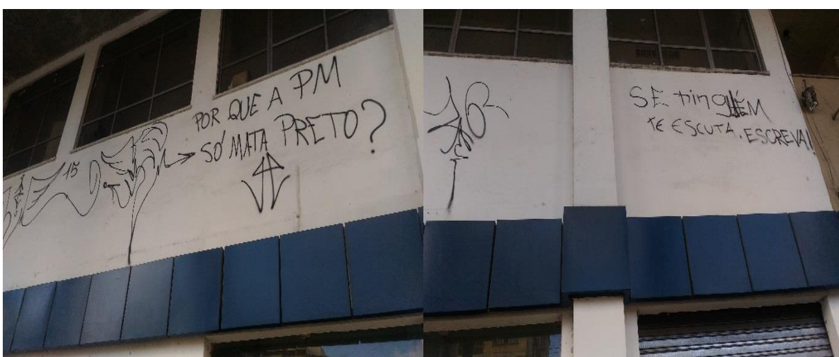
Na fachada do prédio da agência bancária no Aquidabã
