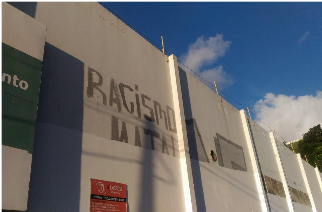
Muro da Fábrica de Macarrão na saída do Túnel Américo Simas
