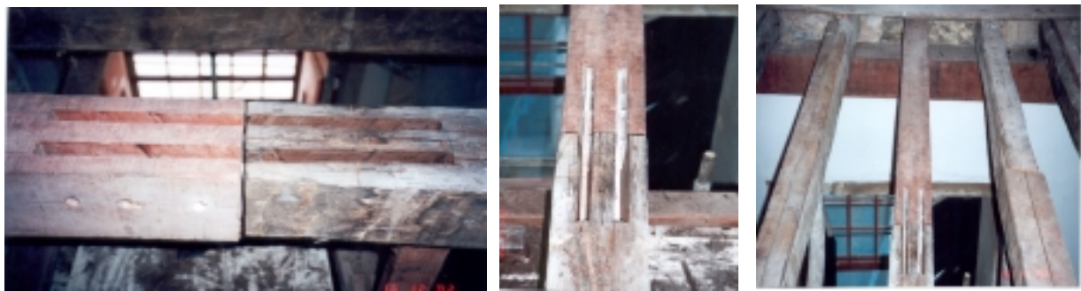
Figura 8 – Proposta de intervenção 2 - barrote e placas de FRP posicionados para emenda
