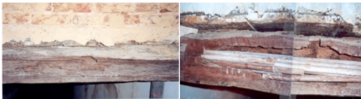
Figura 6 – Intervenção 1 – recomposição do barroto
