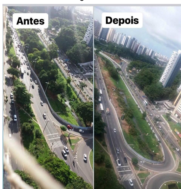
Figura – 5 Antes e depois do início das obras do BRT, onde é possível verificar a supressão vegetal.
