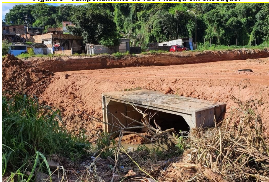
Figura 3 - Tamponamento do Rio Pituaçu em execução.
