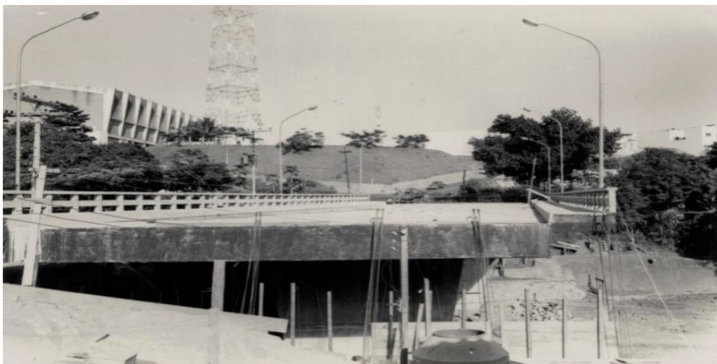
Figura 15 - RECONSTRUÇÃO DO VIADUTO DE LIGAÇÃO ENTRE A RUA CAETANO MOURA E A AVENIDA CARDEAL DA SILVA
