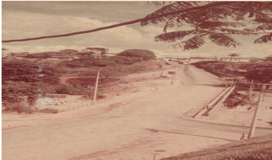
Figura 14 - VIADUTO ENTRE A RUA CAETANO MOURA E A AVENIDA CARDEAL DA SILVA
