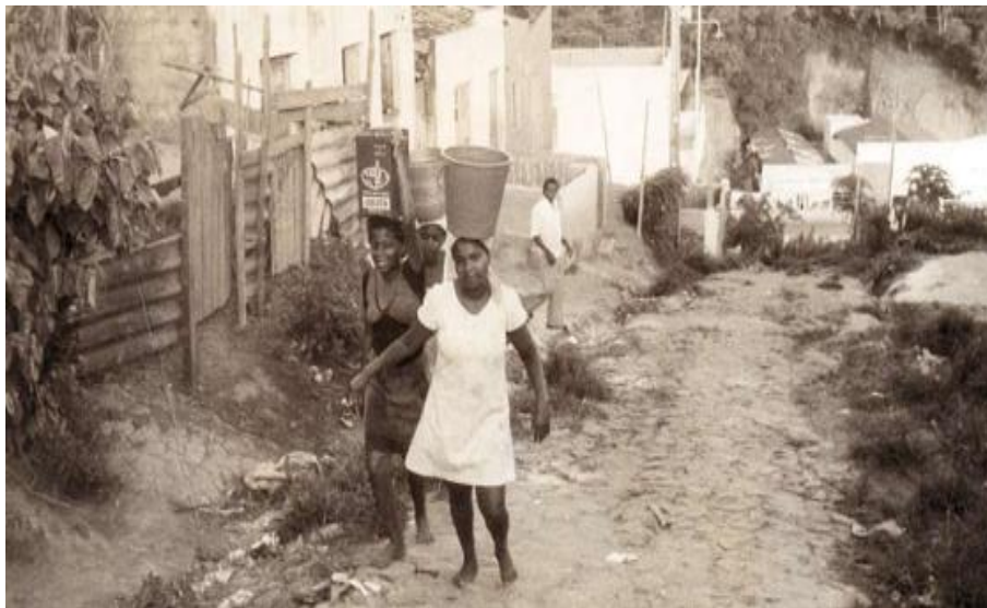
Figura 9 - RUA DAS PALMEIRAS, NA DÉCADA DE 1970
