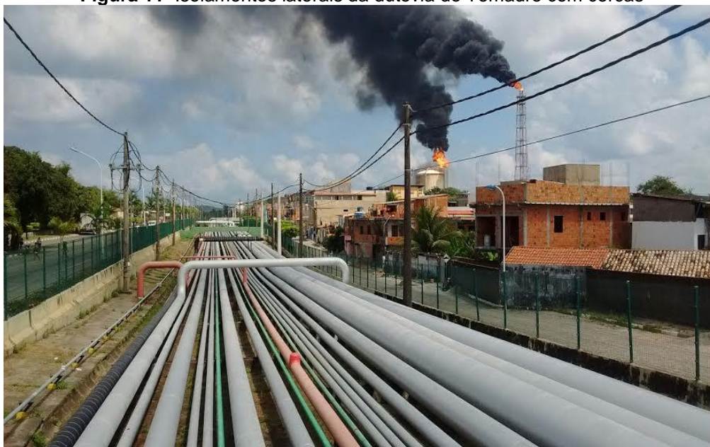
Figura 11 —Isolamentos laterais da dutovia do Temadre com cercas
