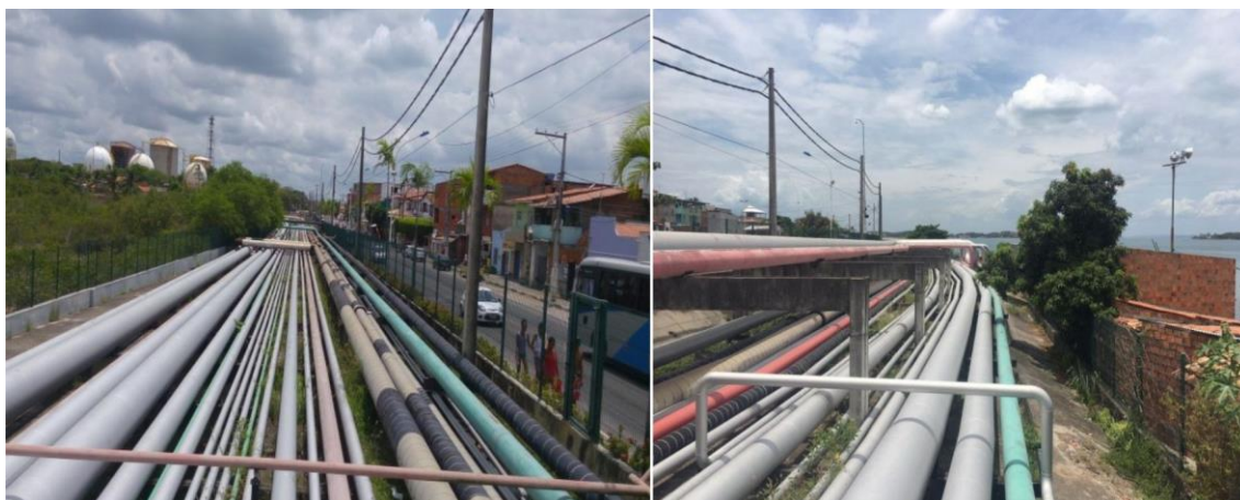
Figura 13 —Proximidade da dutovia da rodovia BA 523 e das residências
