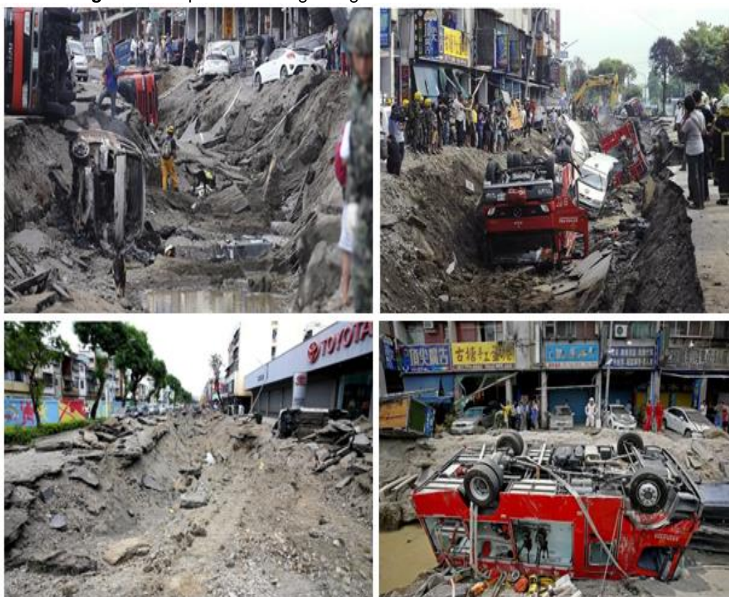
Figura 17 –Explosão ao longo do gasoduto da LCY Chemical em Taiwan
