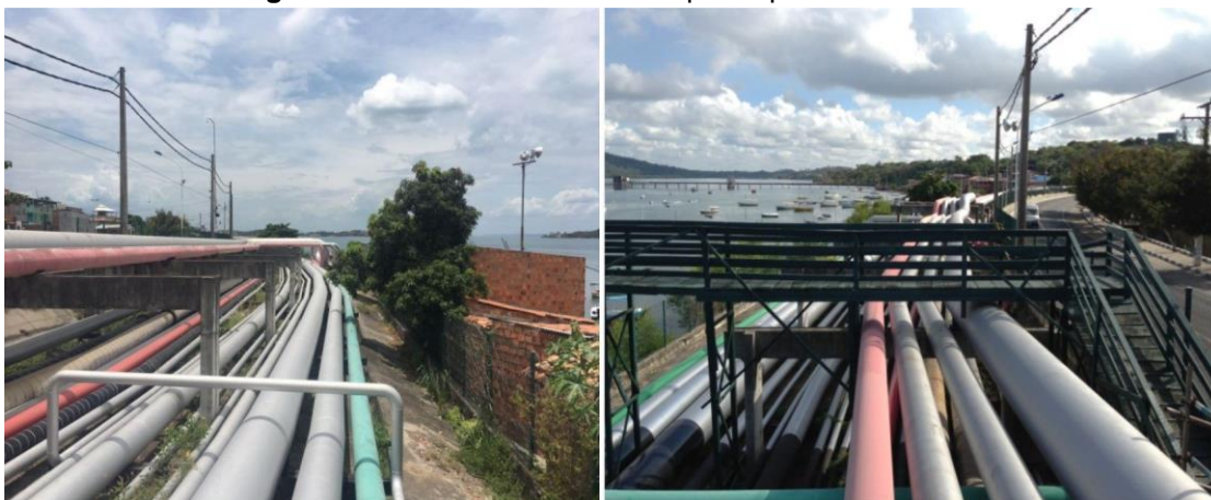
Figura 12 —Estruturas de concreto para apoio dos dutos elevados
