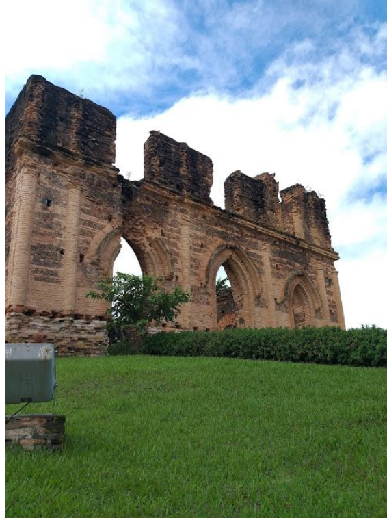
Figura 3: Fachada Frontal das Ruínas da Igreja Inacabada.
