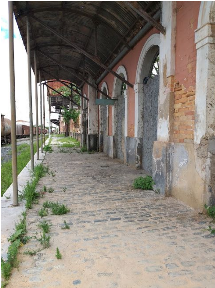
Figura 63: Calçadas do entorno da edificação.
