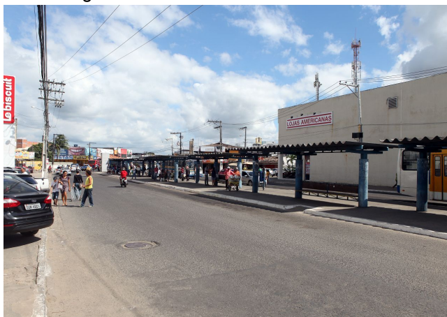
Figura 32: Terminal Rodoviário Urbano
