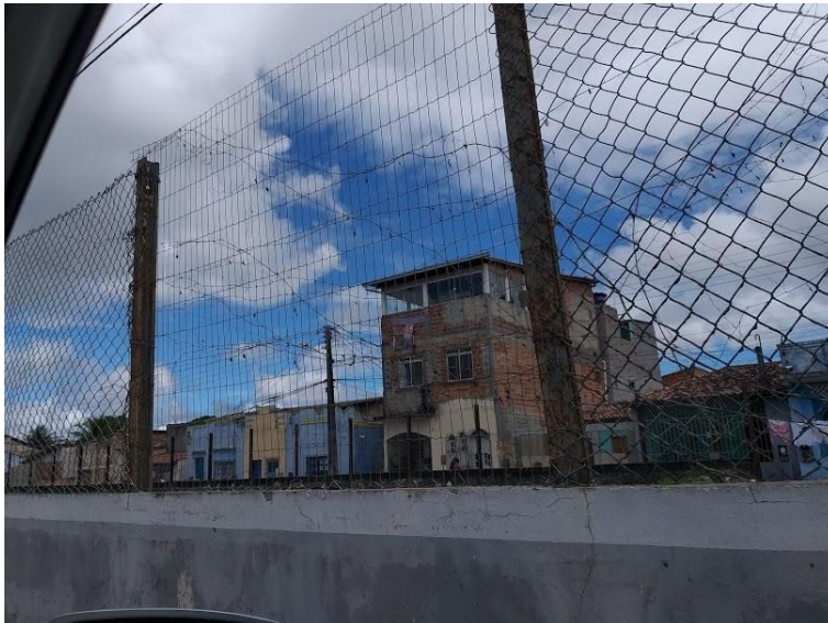
Figura 41: Edificações localizadas na Rua Dois de Julho
