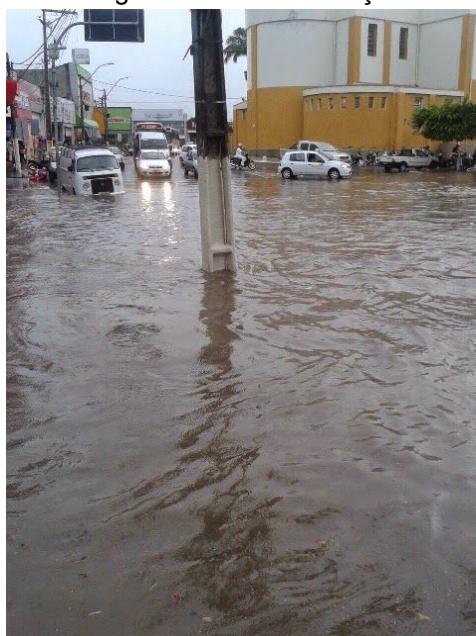
Figura 26: Alagamento na Rua Praça da Bandeira
