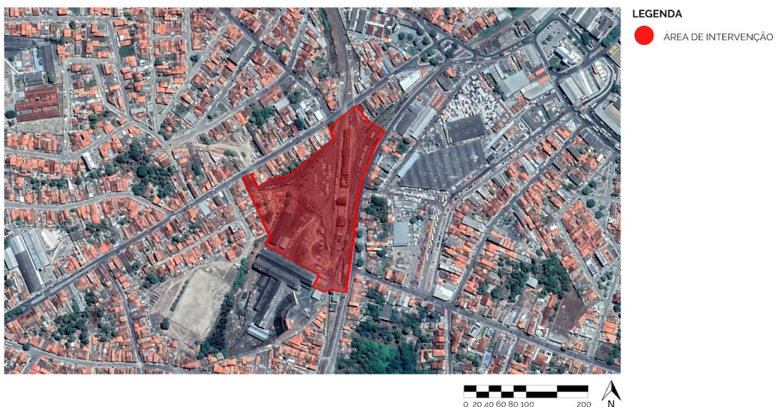
Figura 13: Área de intervenção e entorno em 2019.
