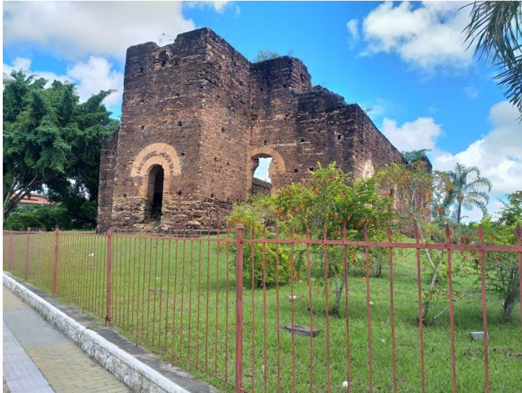
Figura 2: Fachada Posterior das Ruínas da Igreja Inacabada.
