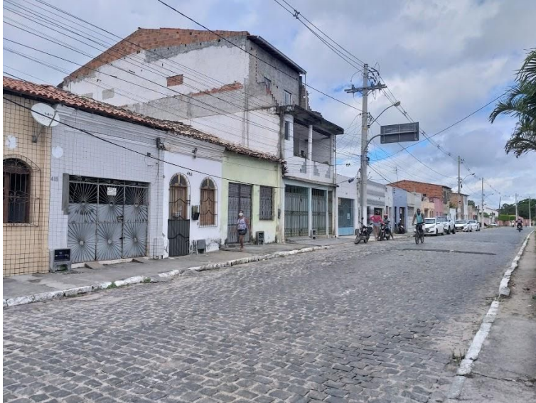
Figura 40: Edificações localizadas na Rua Dois de Julho
