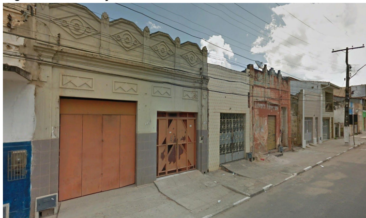
Figura 39: Edificações localizadas na Rua Quinze de Novembro
