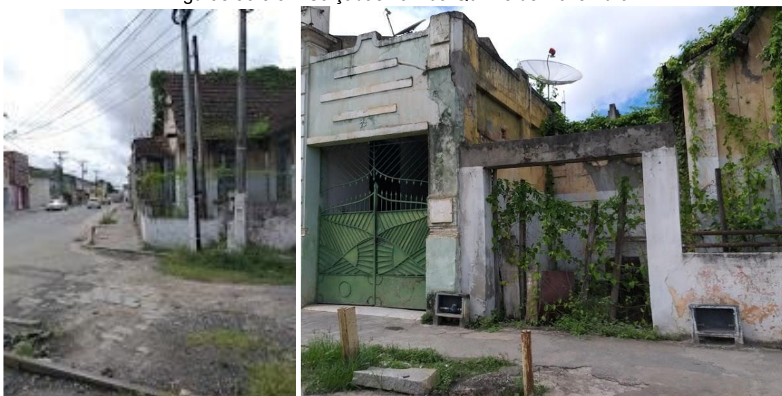
Figuras 36 e 37: Calçadas na Rua Quinze de Novembro
