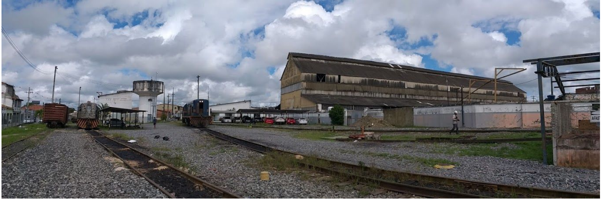
Figura 62: Entorno da área de intervenção.
