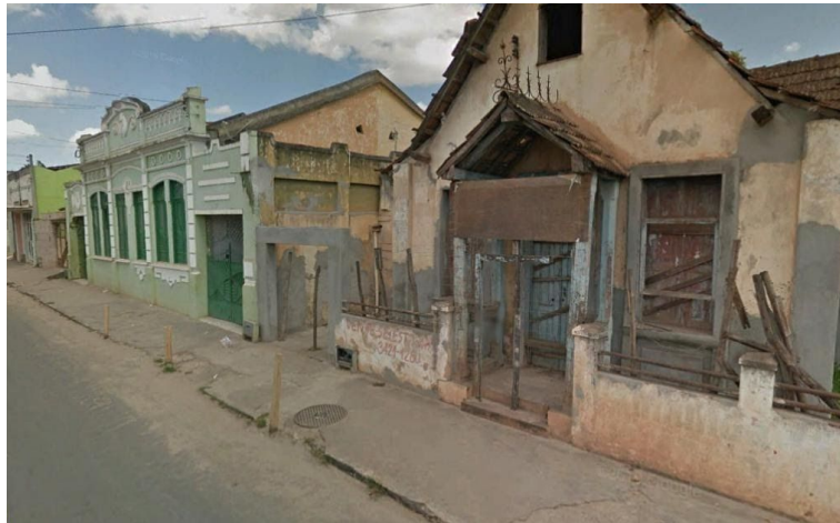
Figura 38: Edificações localizadas na Rua Quinze de Novembro
