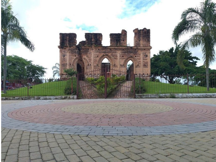
Figura 1: Fachada Frontal das Ruínas da Igreja Inacabada.
