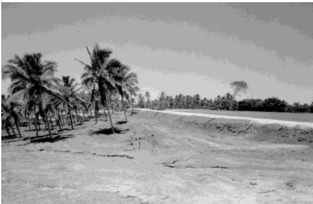
Figura 4 – Supressão de vegetação e terraplanagem para construção do CMS.
