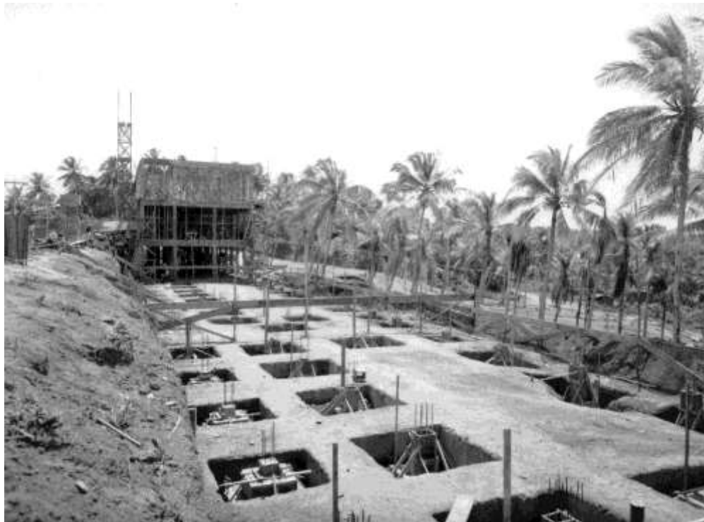
Figura 5 – Obras de construção do Pavilhão Duque de Caxias.
