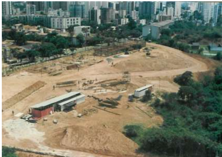
Figura 7 – Canteiro de obras para construção do Pavilhão Sargento Marques.
