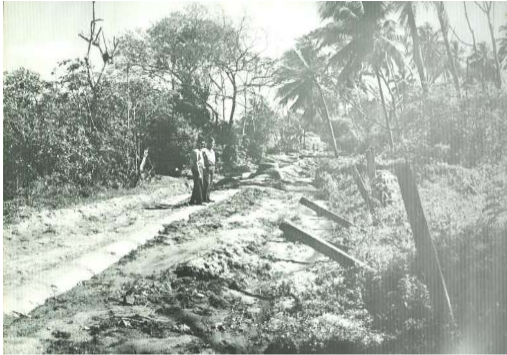
Figura 3 – Reconhecimento da área para a construção do CMS.
