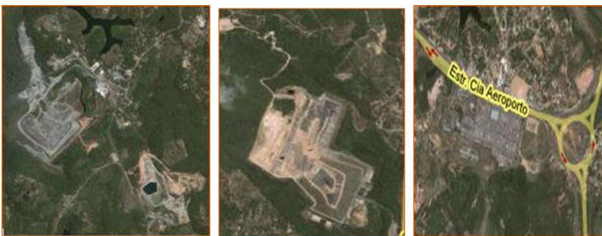
Figura 26 – Área com intervenções diversas.
