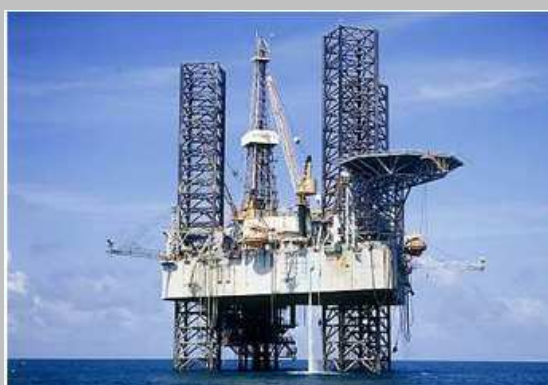
Plataforma Auto-elevatória (PA-6)
