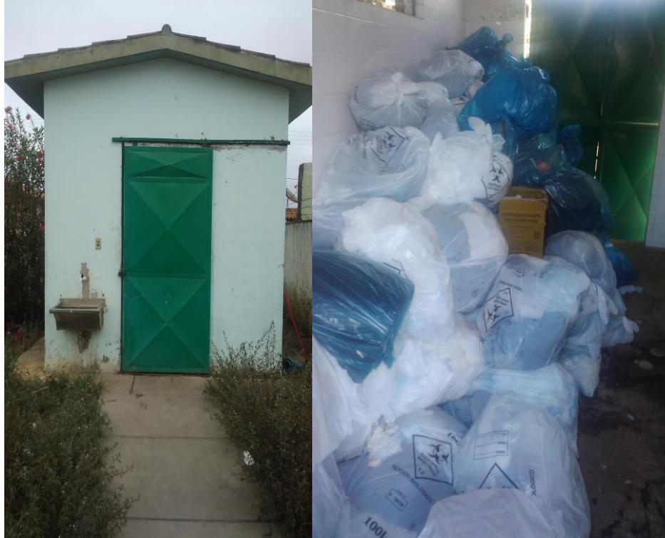
Figura 8 - Casa de resíduos e o armazenamento interno de resíduos
