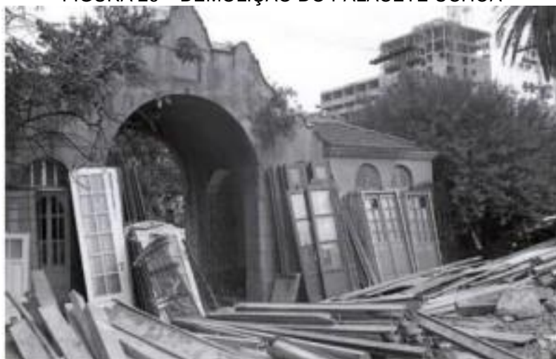
FIGURA 26 – DEMOLIÇÃO DO PALACETE UCHÔA
