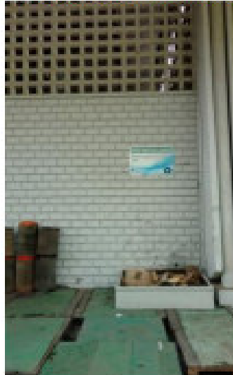
Foto 07 – Sala de armazenamento de resíduos - Não recicláveis
