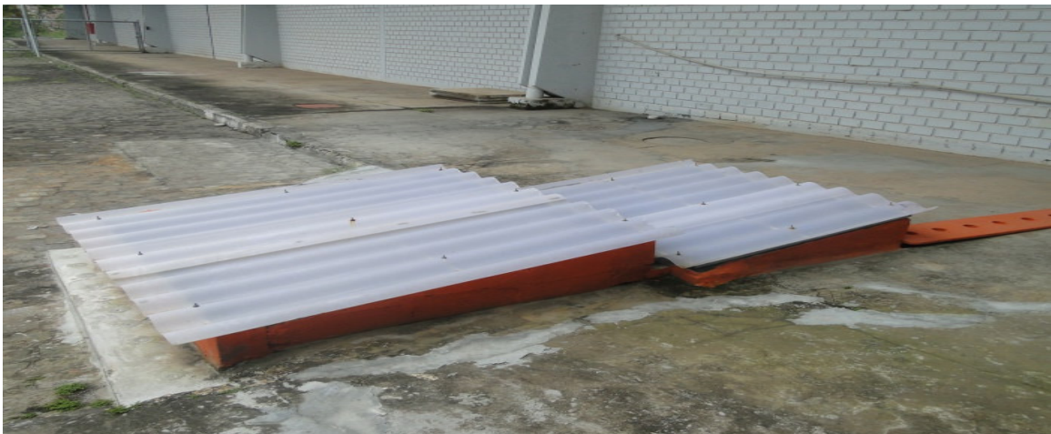
FIGURA 6: Caixa Separadora de Água e Óleo – SAO fechada
