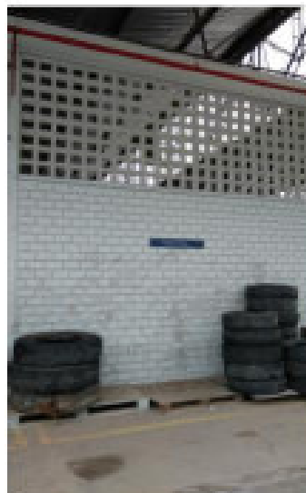
Foto 06 – Baia de armazenamento de resíduos - Sucata de pneus
