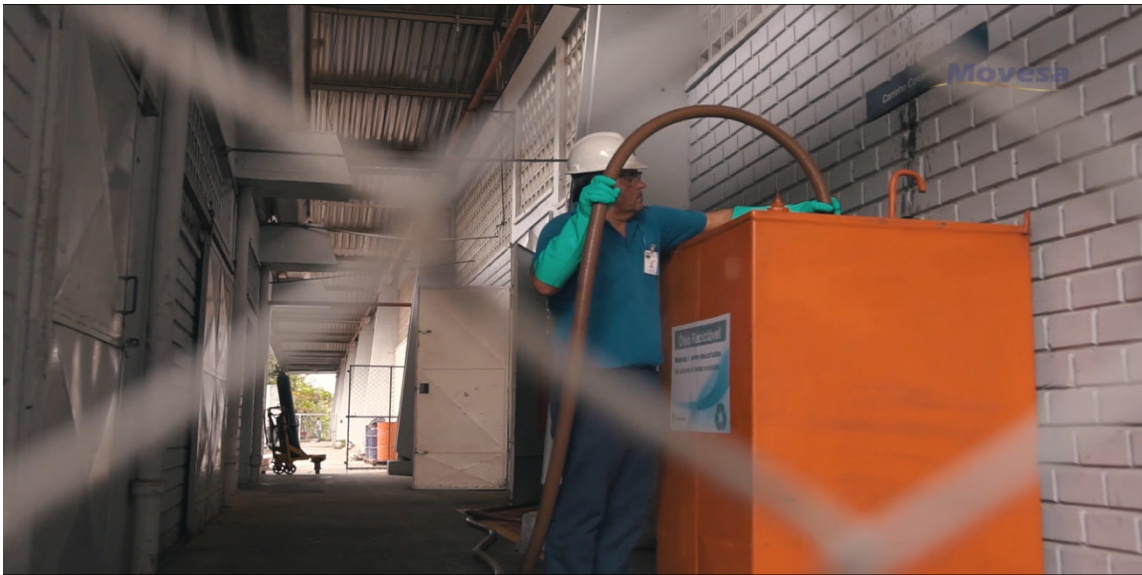
Figura 9: Tanque de armazenamento temporário do OLUC
