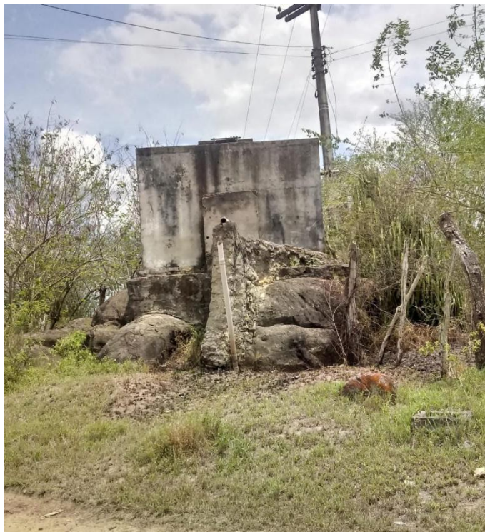
Figura 14 – Exemplo de poço artesiano desativado na Agrovila do Sobrado - 2021
