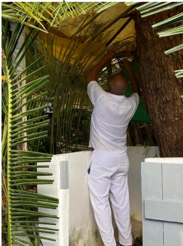
Figura 27 – Manutenção na casa do Caboclo do Terreiro
