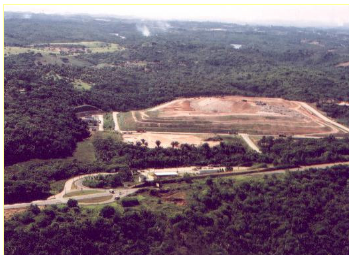
Figura 2 – Vista aérea do aterro metropolitano centro – AMC
