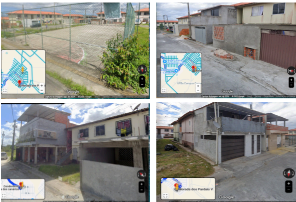
Figura 16 - Características estruturais das UH do MCMV-FAR modificadas (bairro Limoeiro)
