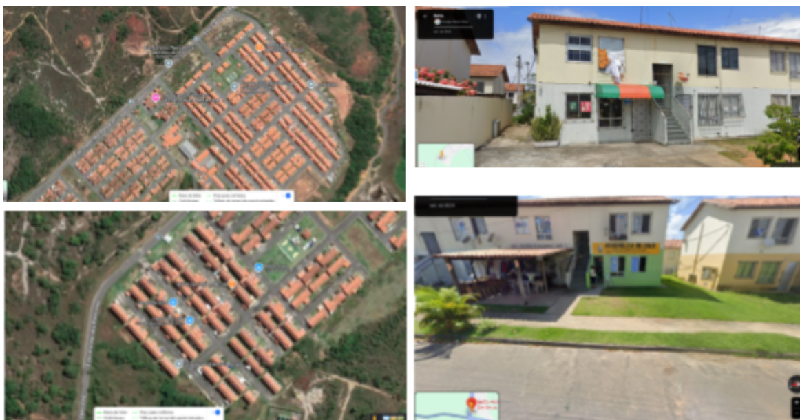
Figura 18 - Unidades habitacionais do MCMV-FAR utilizadas para serviços em Barra do Jacuípe, Camaçari/BA
