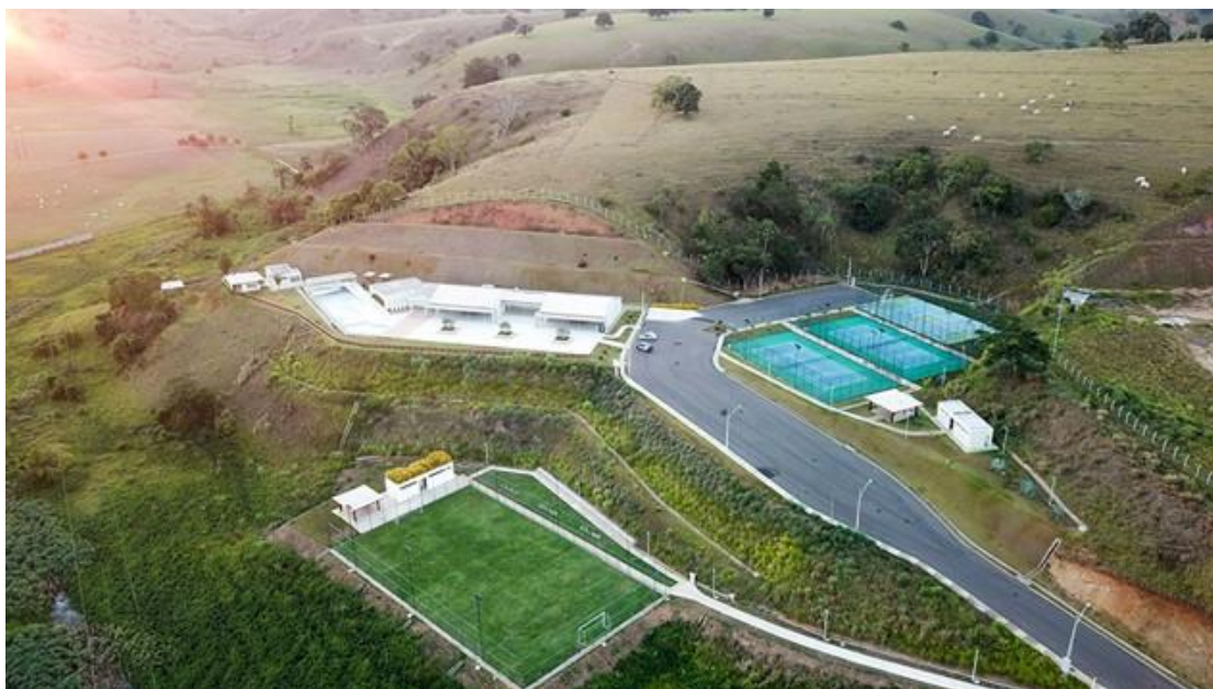
Figura 24 - Vista do Condomínio Alfa Parque Recôncavo, Santo Antônio de Jesus – 2021
