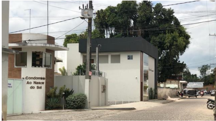
Figura 5 - Condomínio “Ao Nascer do Sol” - Santo Antônio de Jesus, BA - 1979
