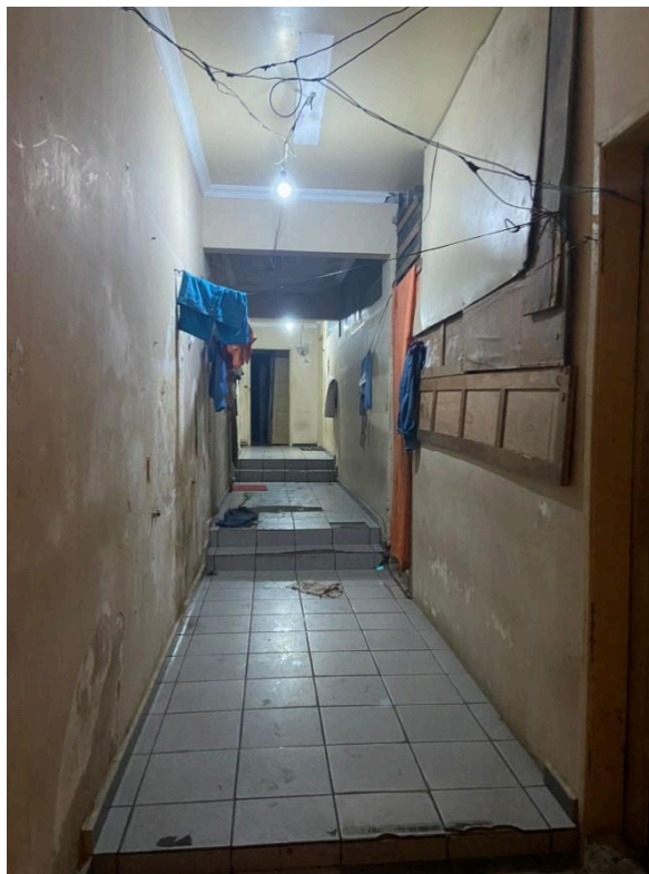
Figura 22. Corredor do primeiro andar da Ocupação
