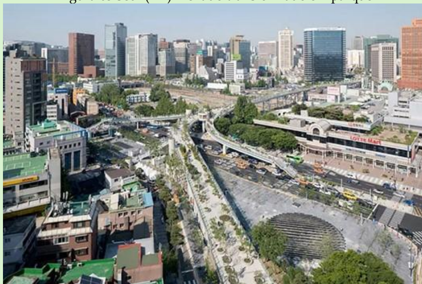
Figura 03 Seul (KR) Elevado transformado em parque
