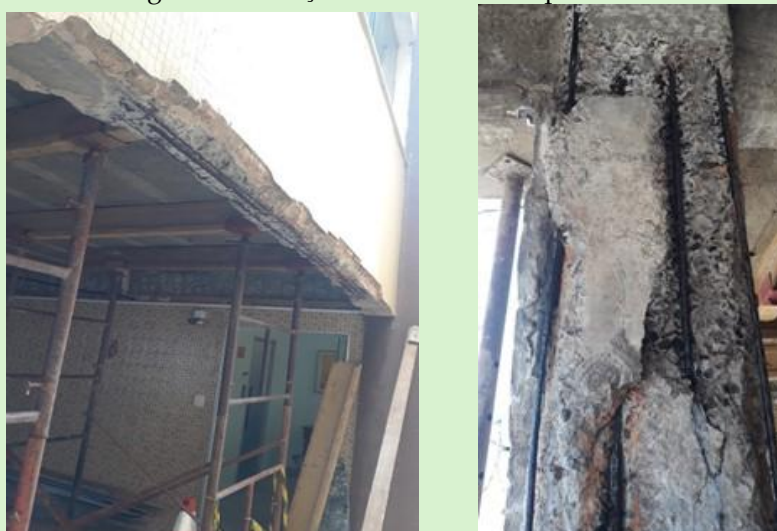
Figura 8: Remoção do concreto comprometido
