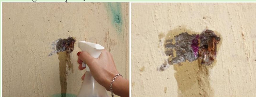
Figura 5: Aplicação da Fenolftaleína no elemento estrutural
