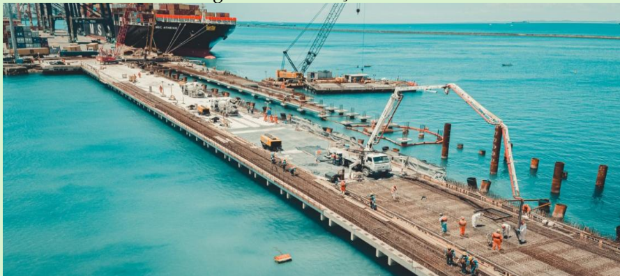
Figura 1: Construção do Cais
