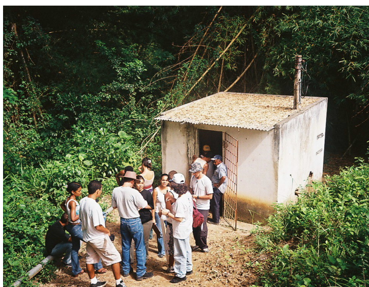
Figura 03: Casa de proteção de bomba
