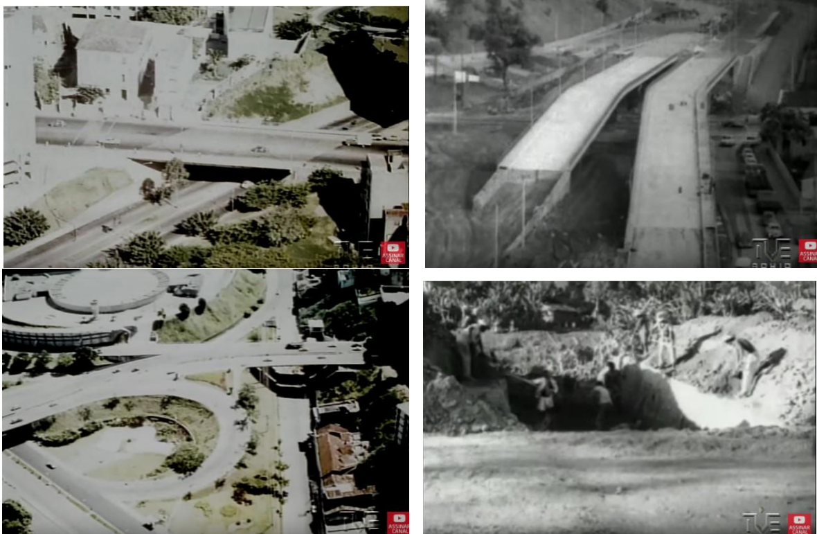
Figura 47 Imagens das aberturas das Avenidas de Vale Salvador (BA)
