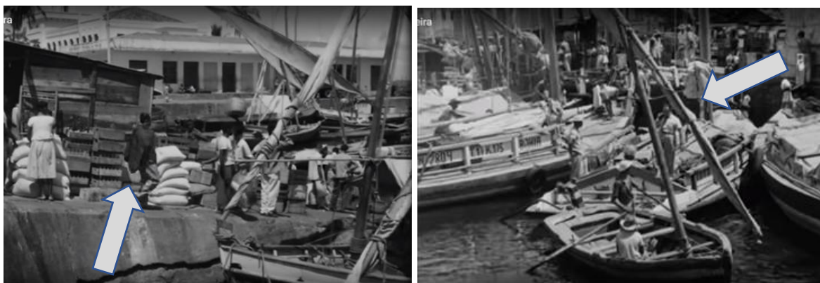
Figuras 106 e 107 Rampa do Mercado
