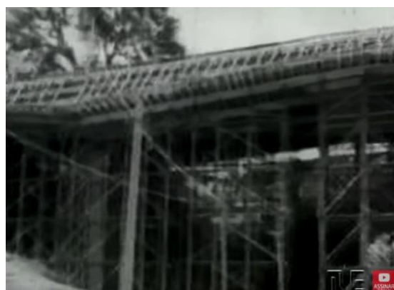
Figura 50 do Moderno Viaduto Salvador
