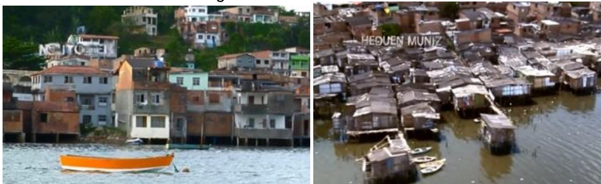
Figura 197 Casas de Palafitas
