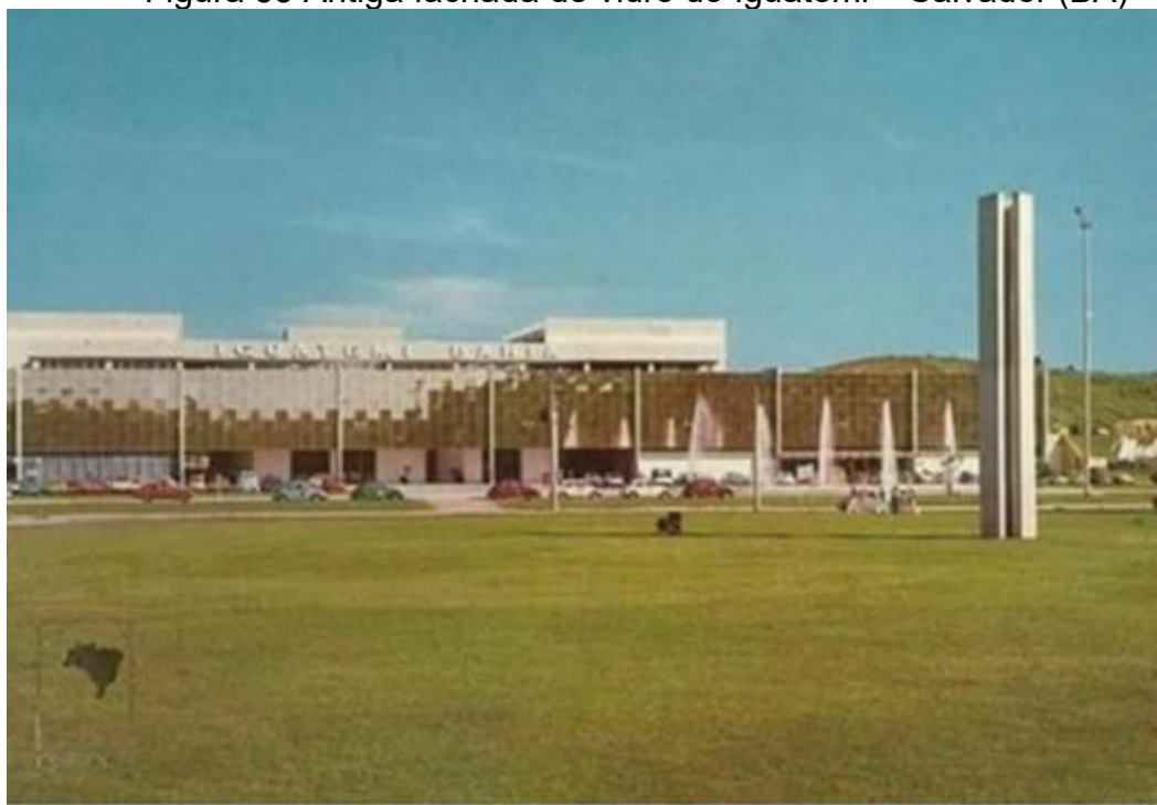
Figura 53 Antiga fachada de vidro do Iguatemi – Salvador (BA)
