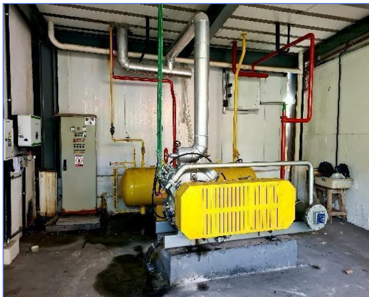
Figura 11 - Registros da Infraestrutura da Colônia de Pesca de Barra de Itaípe A
