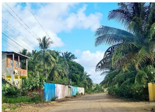
Figura 36 - ruas sem pavimentação em Aritaguá
