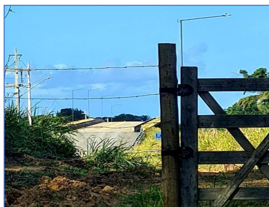
Figura 16 - Estrada de Ferro sobre o Rio Almada
