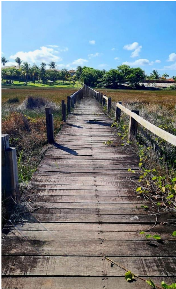
Figura 5: Pontilhão de acesso à praia de Itacimirim
