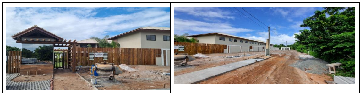
Figura 6: Condomínios em construção na Ilha do Meio
