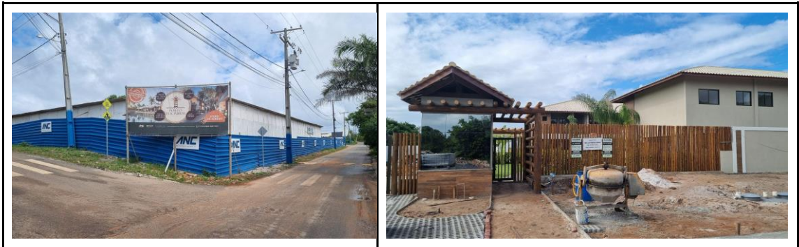
Figura 7: Construção de empreendimentos na Ilha do Meio
