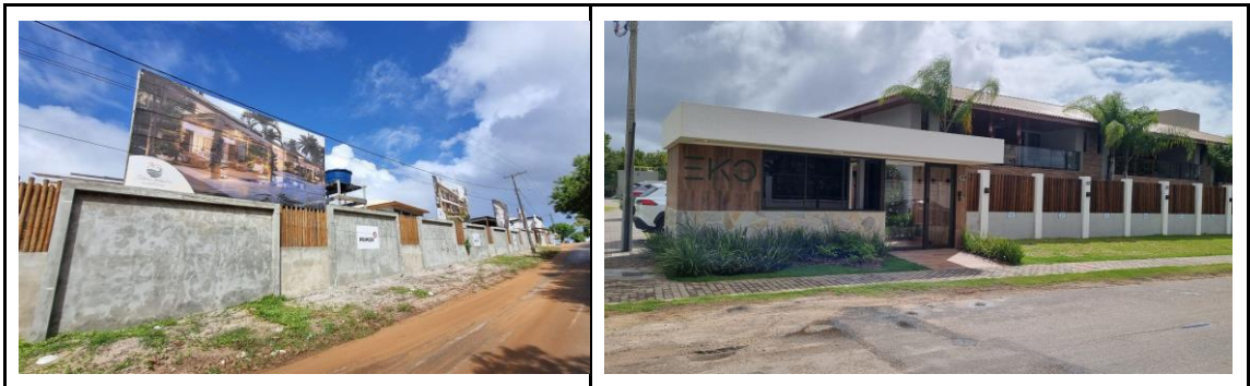
Figura 8: Fachada de condomínio
