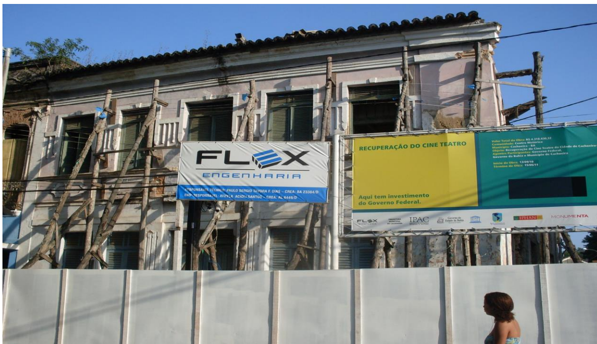
Figura 11 – Cine Teatro Cachoeira em ruínas recebendo os preparativos para reconstrução
