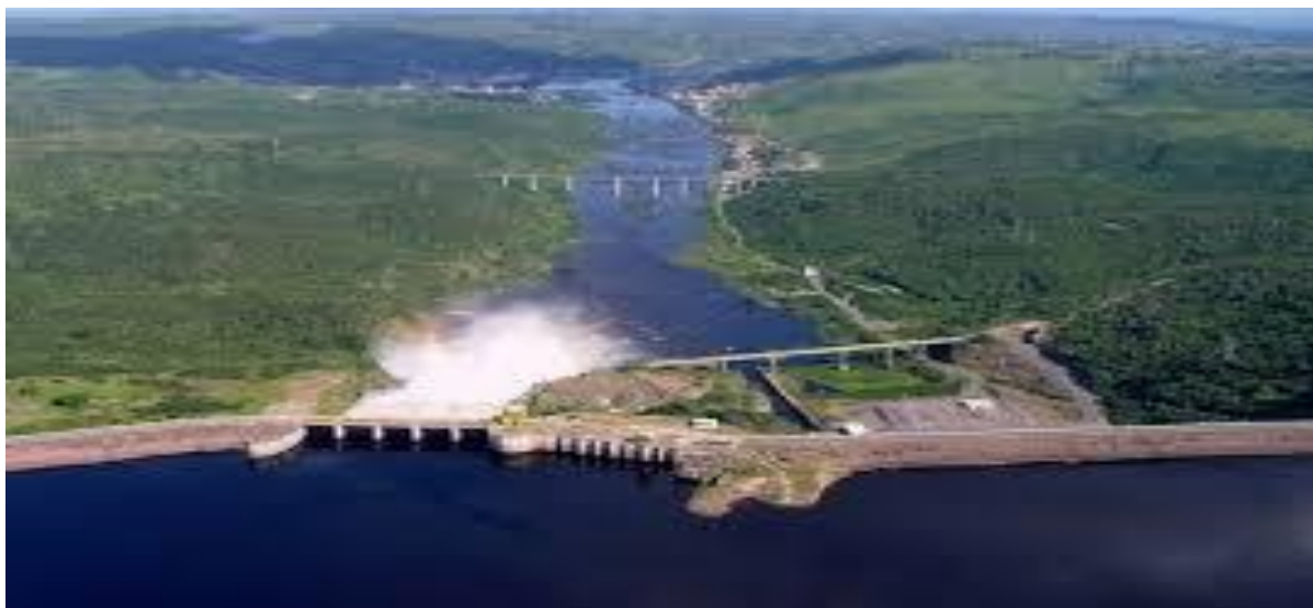
Figura 18 – Barragem Pedra do Cavalo, Br 101, vista para Cachoeira e São Félix
