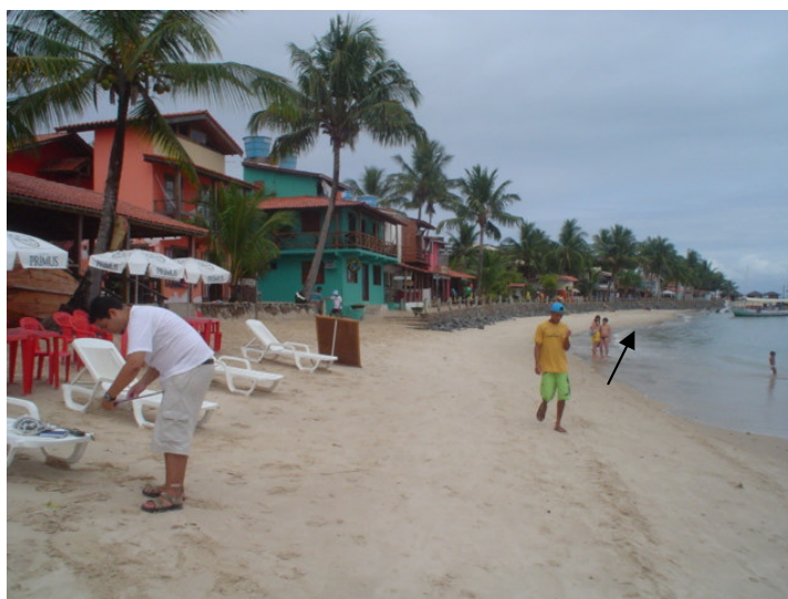
Foto 3 – Muro de proteção à erosão na Segunda Praia, em Morro de São Paulo.
