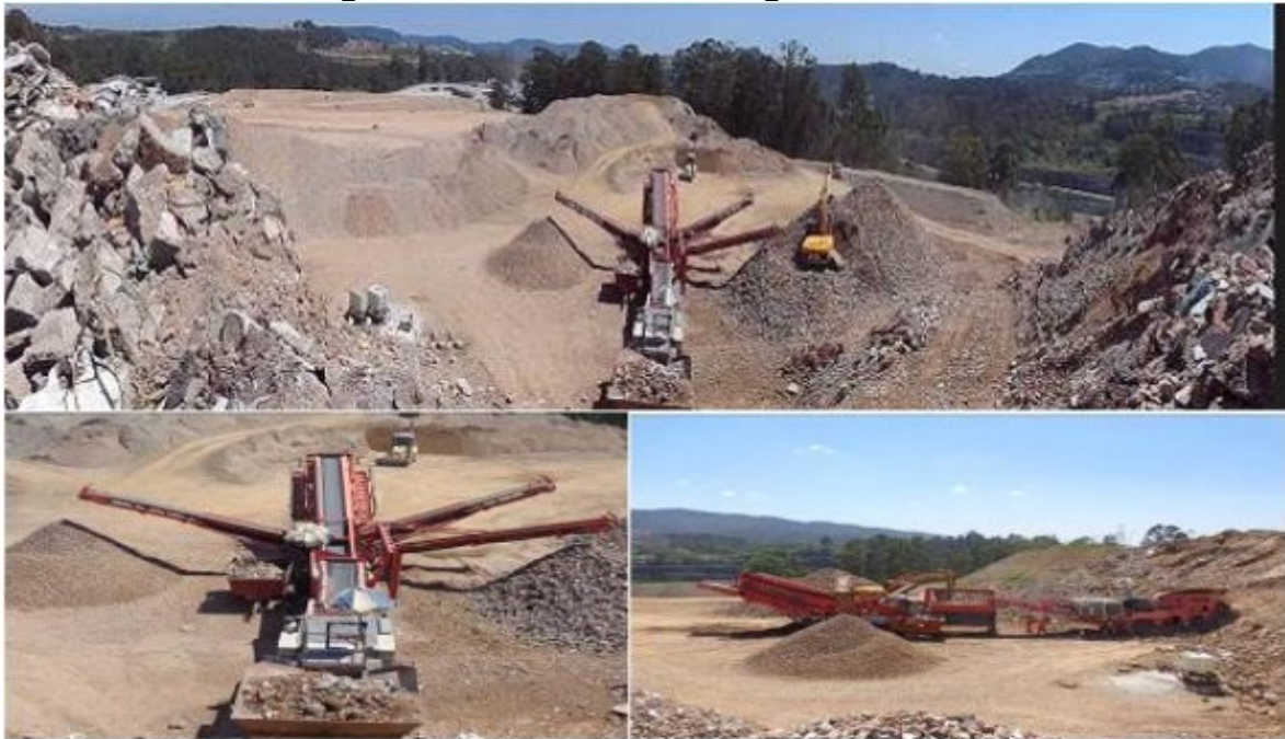
Figura 2 – Usina de Reciclagem de Entulho
