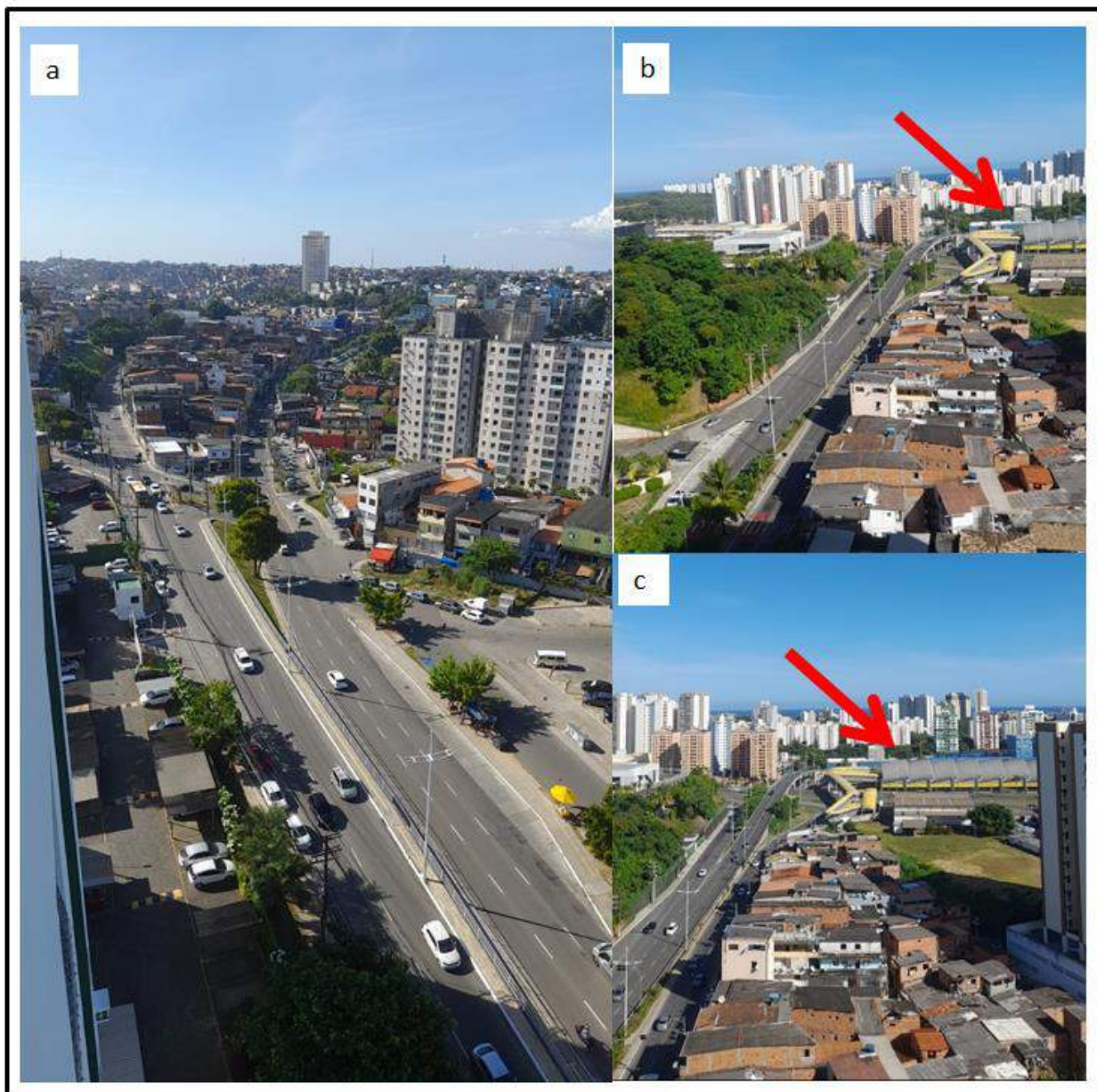
Figura 40 - Canteiro central e estação de metrô Imbuí
