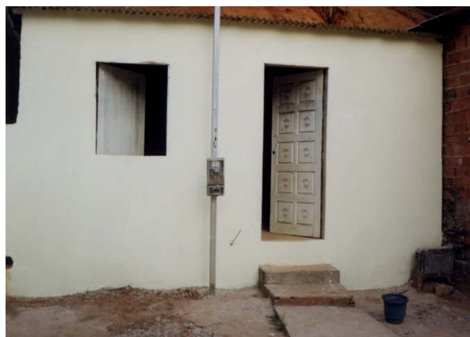
Figura 4 – Reboco na área externa da casa
