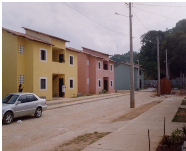
Figura 3 – Conjunto habitacional de Vila Nova de Pituáçu.
