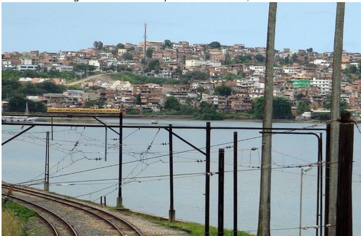
Figura 11 – Vista da Estação Almeida Brandão, em Plataforma
