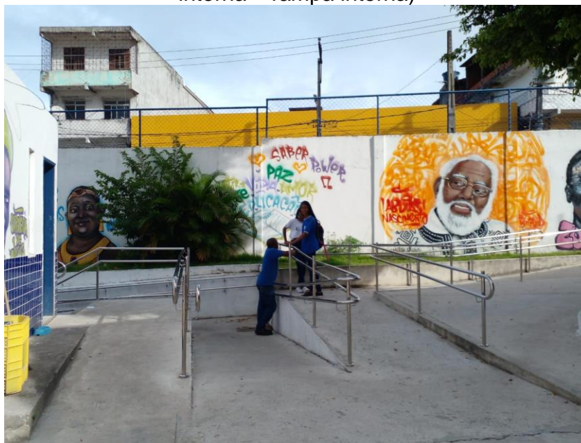
Figura 8 – Colégio Estadual Edvaldo Fernandes em Salvador/BA - jan. 2023 (área interna – rampa interna)
