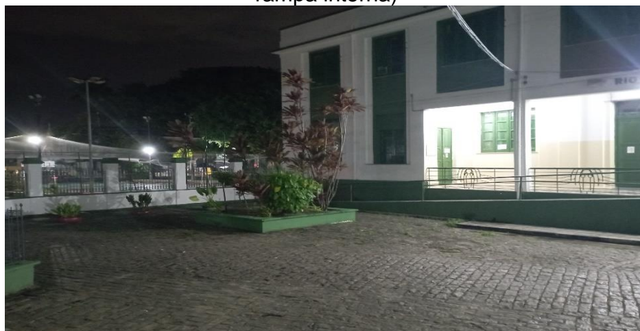
Figura 9 - Colégio Estadual Central em Salvador/BA - jan. 2023 (área interna – rampa interna)
