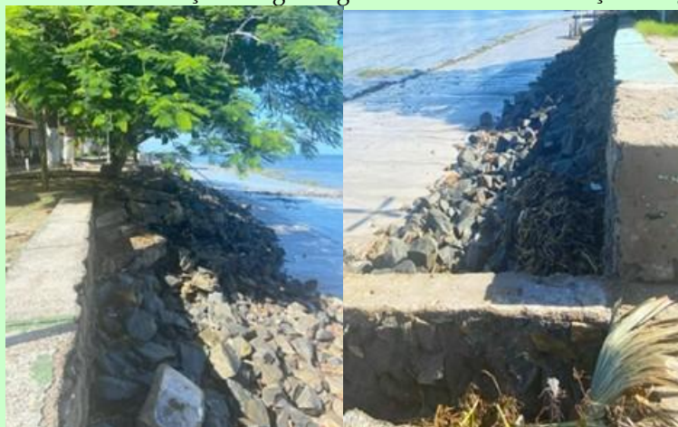
Figura 6: Trecho de contenção antiga Figura 7: Trecho de contenção antiga
