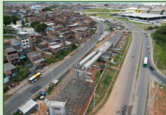
Fundações VLT Lote 2
