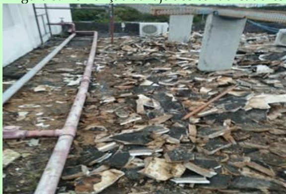
Figura 5: Demolição da laje dos condensadores
