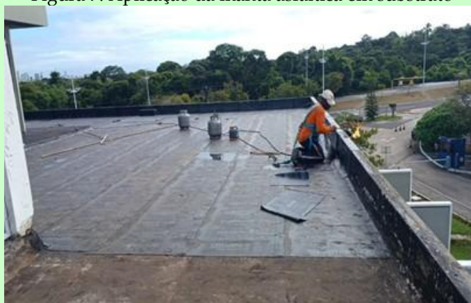
Figura 7: Aplicação da manta asfáltica em substrato
