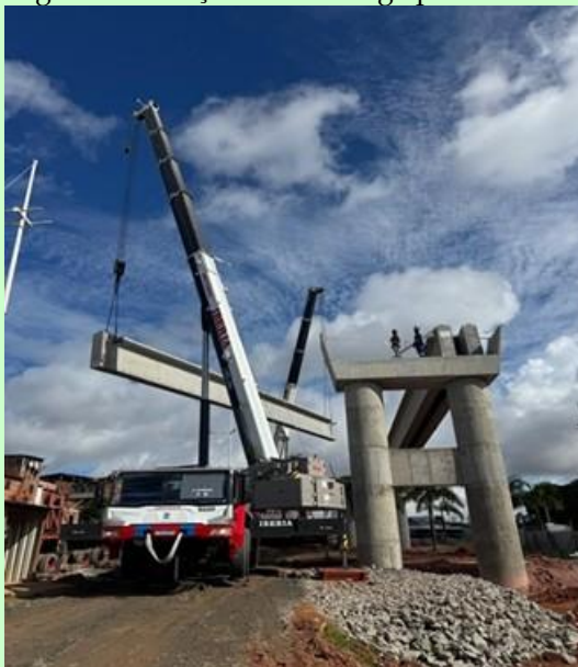
Figura 6 – Lançamento de viga pré-moldada
