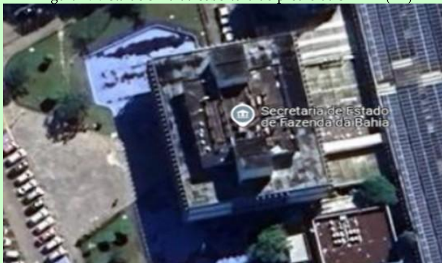
Figura 4: Vista de cima da cobertura do prédio da SEFAZ-(BA)
