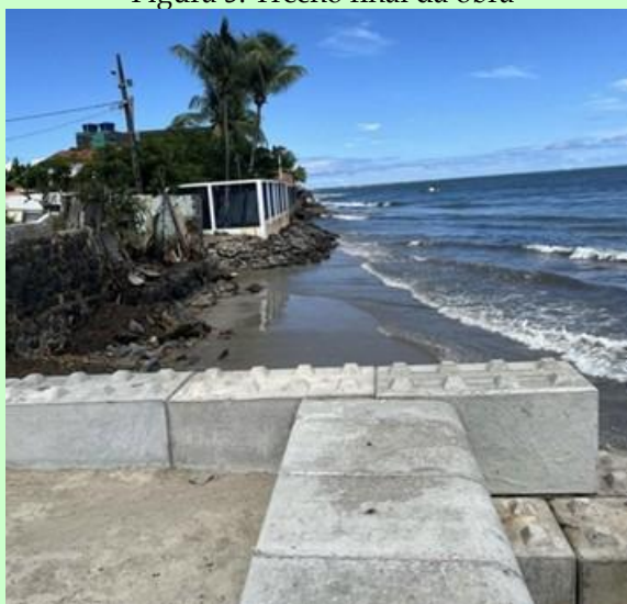
Figura 5: Trecho final da obra
