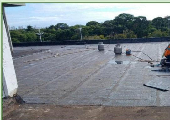
Impermeabilização no SEFAZ
