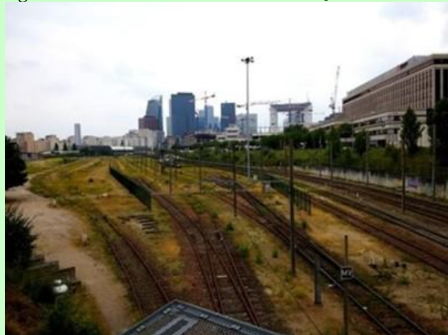
Figura 3 - Les Groues , antes da intervenção de 2015-2018
