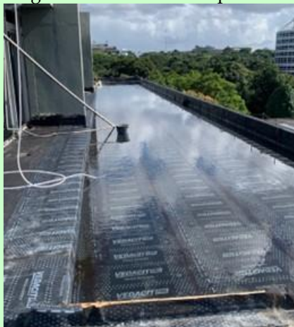
Figura 8: Teste de Estanqueidade
