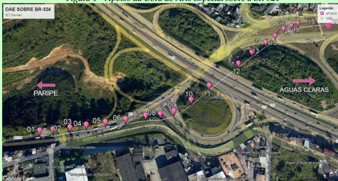
Figura 4 - Apoios da Obra de Arte Especial sobre a BR-324
