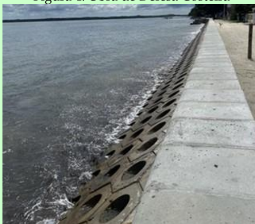
Figura 4: Obra de Defesa Costeira
