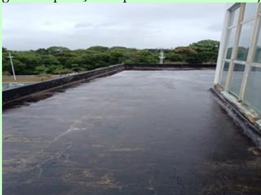
Figura 6 Aplicação de primer em trecho da laje 1
