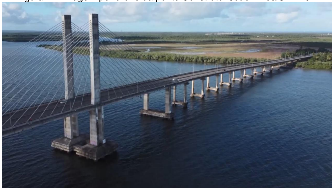
Figura 2 – Imagem por drone da ponte Construtor João Alves/SE - 2021
