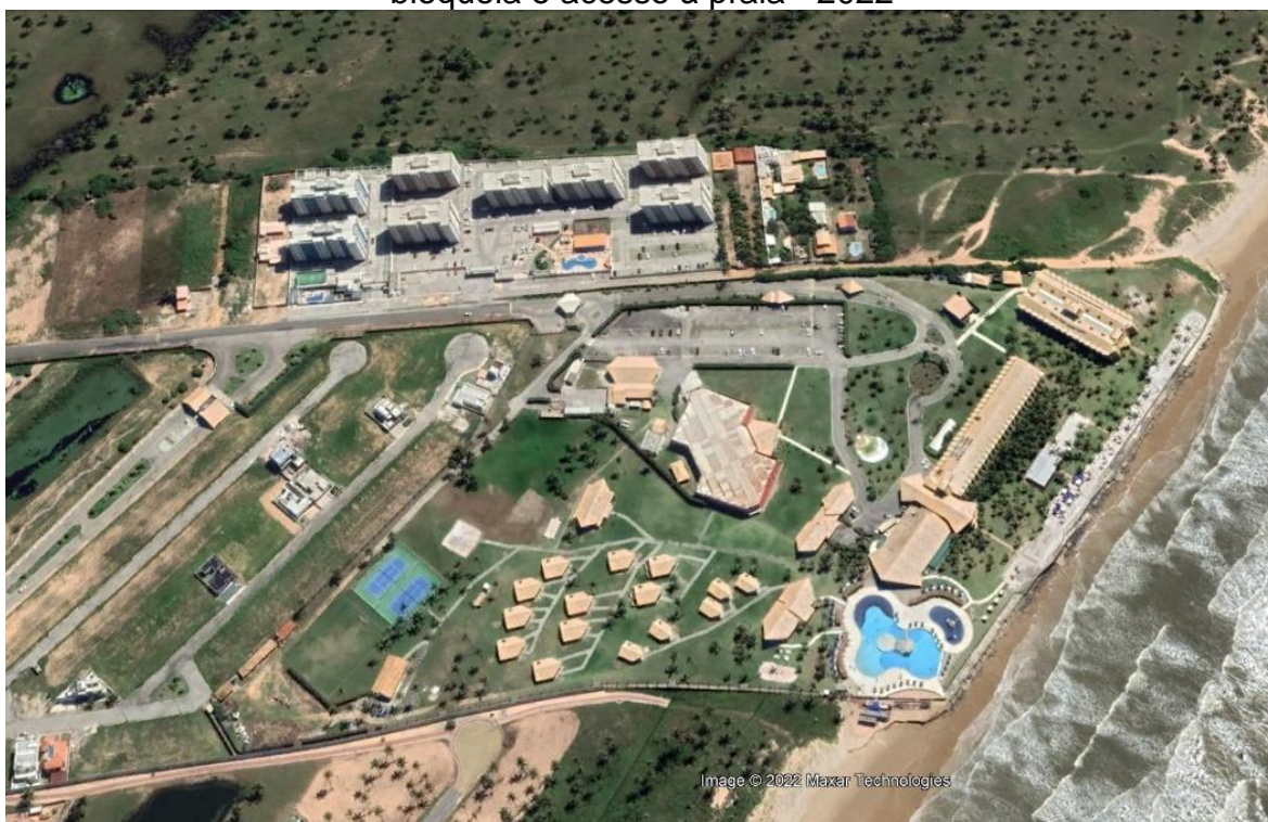
Figura 35 – Makai Resort em Barra dos Coqueiros/SE – Construção que bloqueia o acesso à praia - 2022
