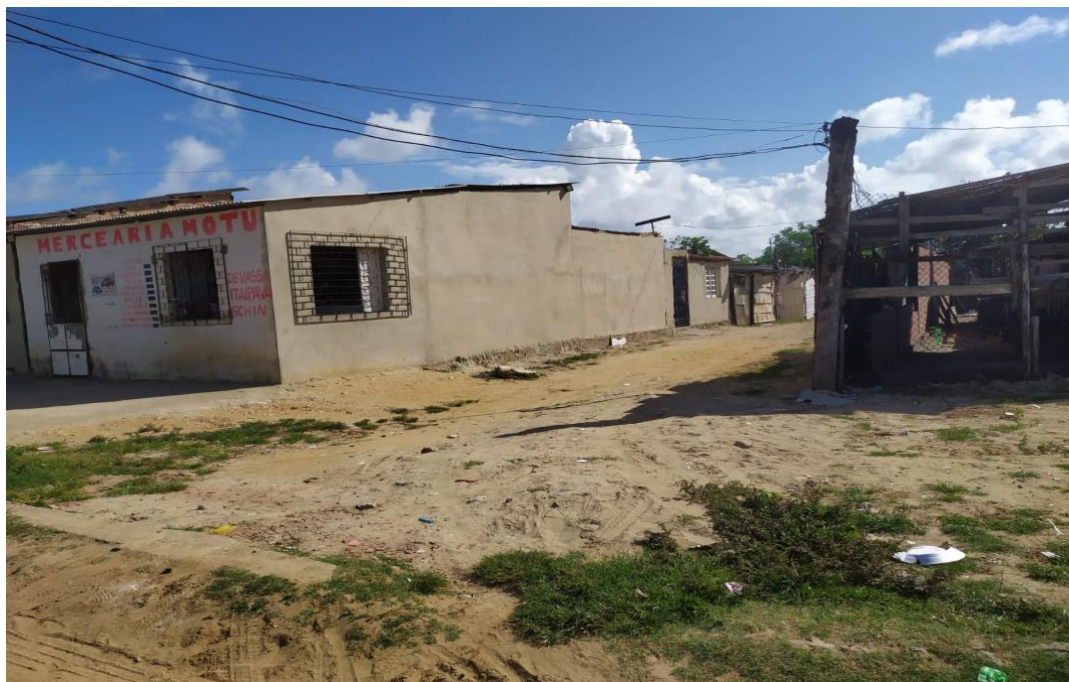
Figura 30 – Casas na ocupação Motu em Barra dos Coqueiros/SE - 2021
