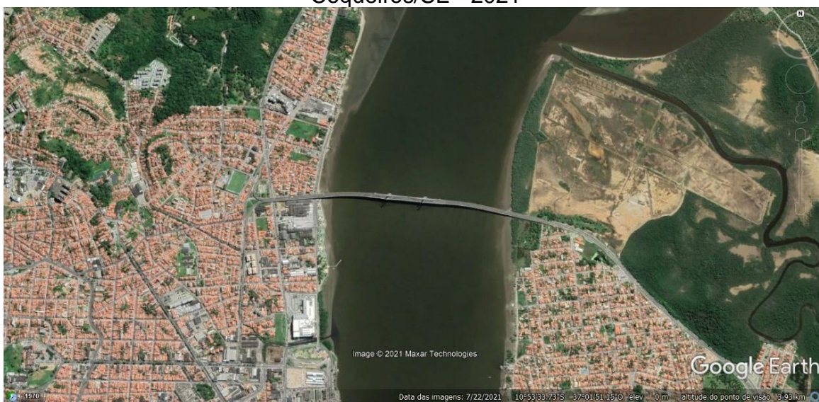
Figura 3 – Ponte Construtor João Alves interligando Aracaju a Barra dos Coqueiros/SE - 2021
