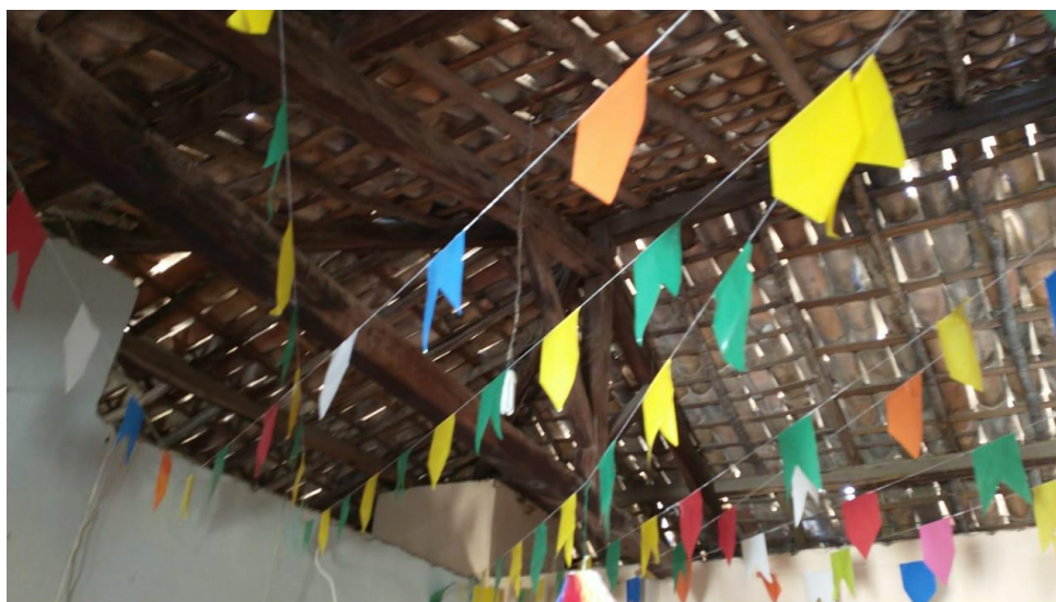
Figura 26: Fotografia do telhado da sala da casa de vó Joaquina (vista interna)
