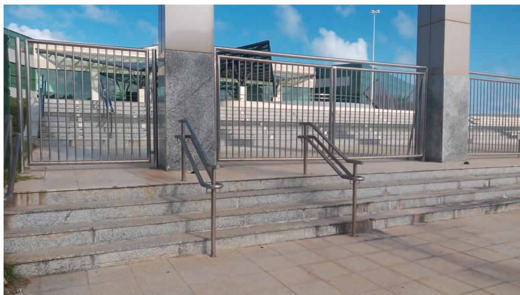
Figura 53 - Escadas do acesso principal
