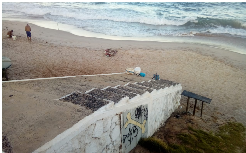
Figura 115 - Rampa na Praia da Pituba
