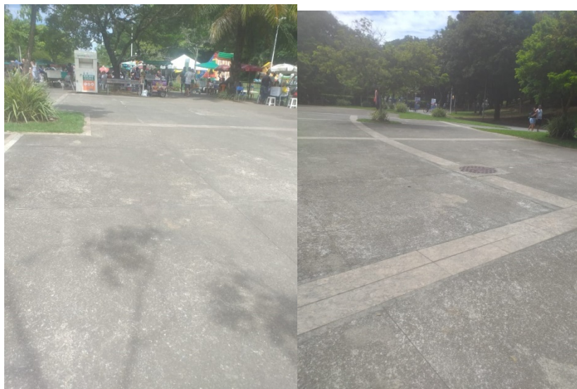
Figura 149 - Vão inicial na entrada do Parque
