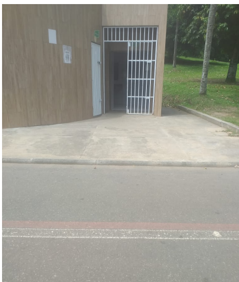
Figura 153 - Porta de acesso ao banheiro
