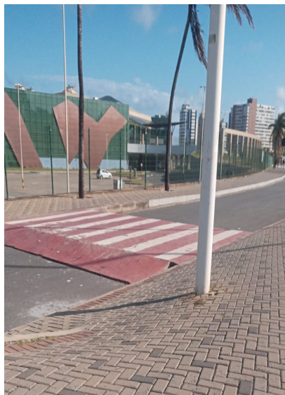
Figura 43 - Redutor de velocidade
