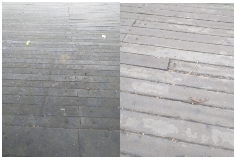
Figura 151 - Piso emborrachado no interior do Parque
