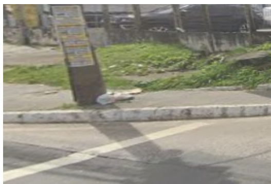
Figura 181 - Calçadas que dão acesso ao restaurante
