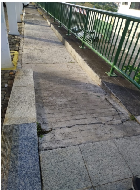
Figura 172 - Rampa no estádio de acesso a Tribuna de Honra
