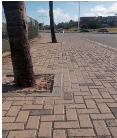
Figura 47 - Calçada (sentido Oeste)
