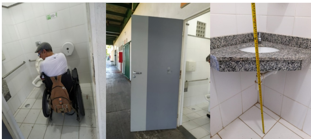
Figura 174 - Sanitários para PcD no Estádio Roberto Santos - 2
