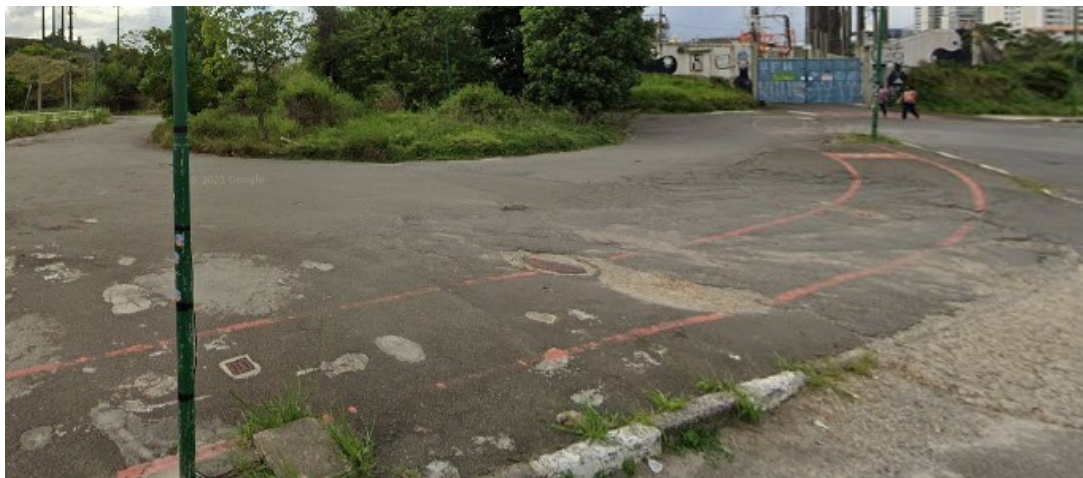
Figura 161 - Acesso ao estádio pelo ponto de ônibus – rebaixamento improvisado
