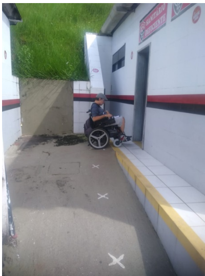
Figura 199 - Acesso por cadeira de rodas ao “sanitário deficiente”
