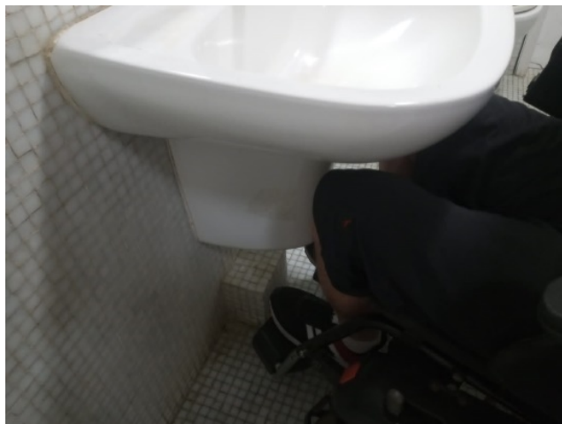
Figura 99 - Aproximação da pia para PcD
