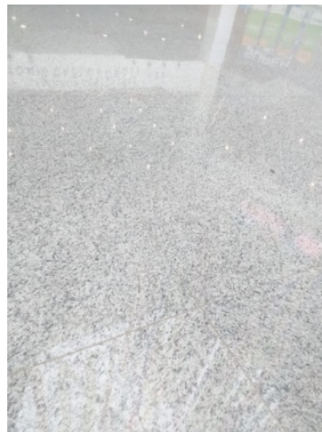
Figura 66 - Piso do ambiente interno
