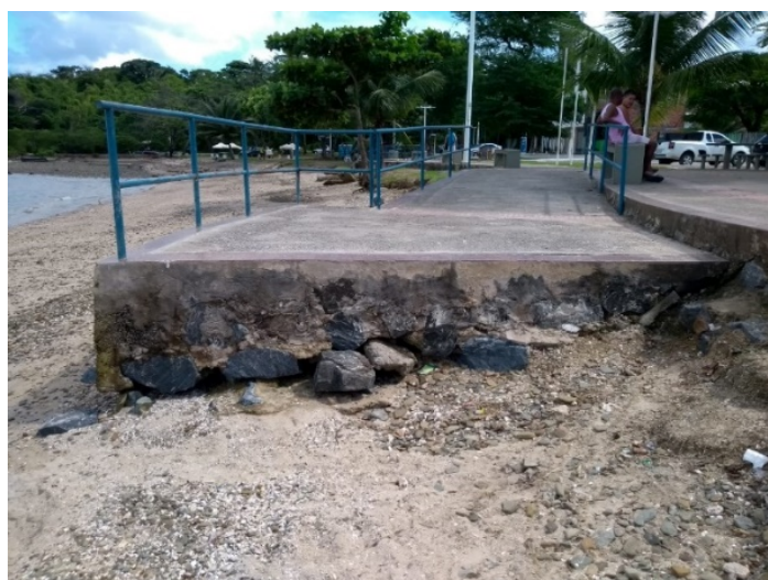
Figura 116 - Rampa com um obstáculo ao final para o acesso à praia de Tubarão
