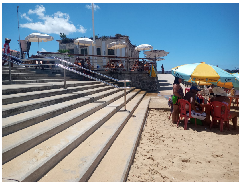
Figura 123 - Escadas de acesso à Praia de Boa Viagem
