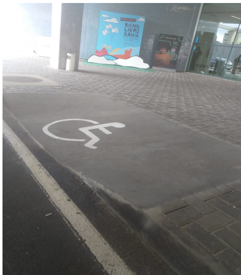
Figura 63 - Rebaixamento de calçadas na entrada do CCS
