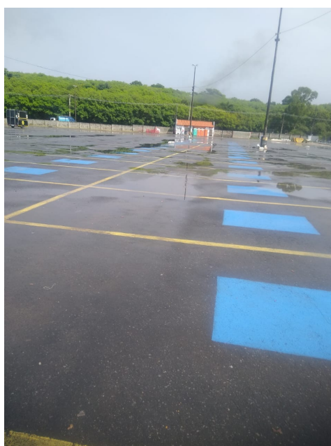
Figura 186 - Vagas reservadas para PcD e PMR em construção
