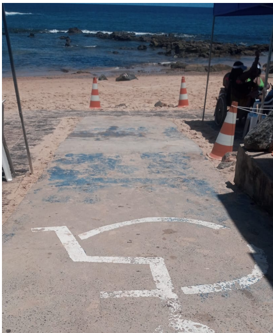
Figura 138 - Estrutura de cimento no Final da primeira rampa
