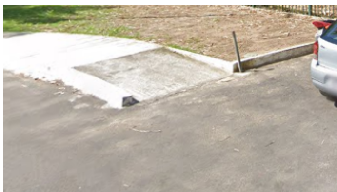
Figura 143 - Acesso à calçada do Parque
