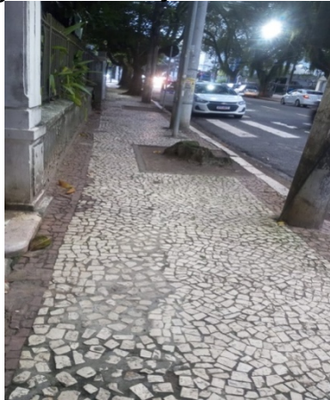
Figura 75 - Calçada externa leste
