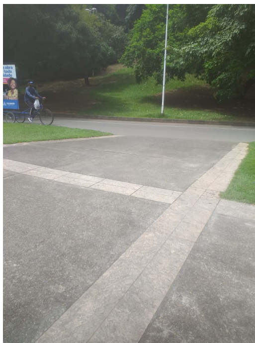
Figura 152 - Rampa que liga à pista interna do Parque
