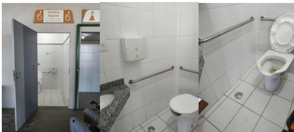
Figura 173 - Sanitários para PcD no Estádio Roberto Santos
