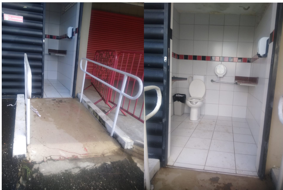
Figura 194 - Primeiro banheiro reservado ao torcedor PcD
