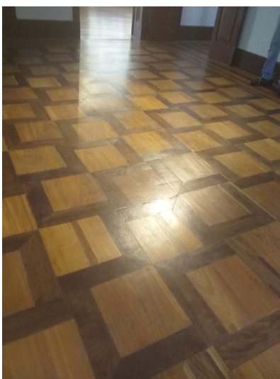
Figura 81 - Piso da área interna
