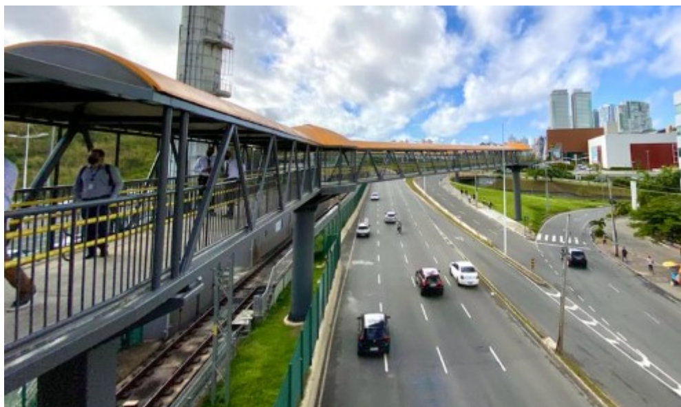
Figura 213 - Passarela de acesso ao Salvador Shopping
