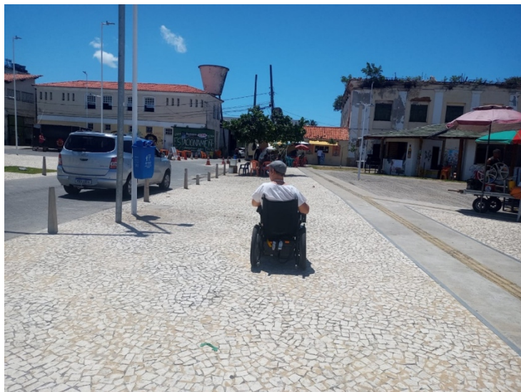
Figura 120 - Piso de pedras portuguesas: Praia de Boa Viagem
