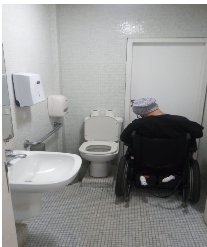
Figura 97 - Espaço para transferência lateral
