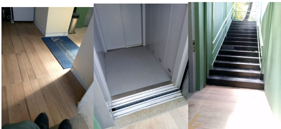
Figura 29 - Pisos, corredores e elevador do Museu Casa do Rio Vermelho
