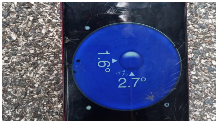
Figura 104 - Inclinação do rebaixamento de calçada
