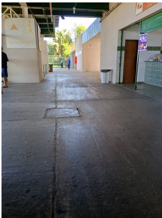
Figura 170 - Corredor da área interna do estádio
