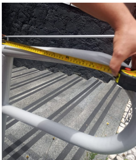
Figura 108 - Prolongamento da escada externa
