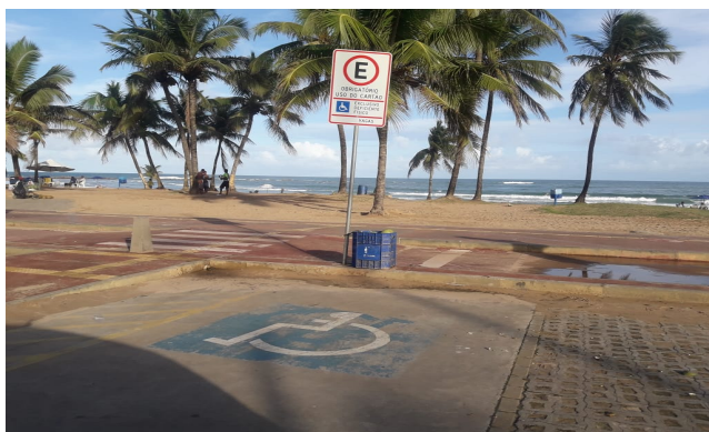
Figura 117 - Praia de Piatã: nível da calçada x nível da praia
