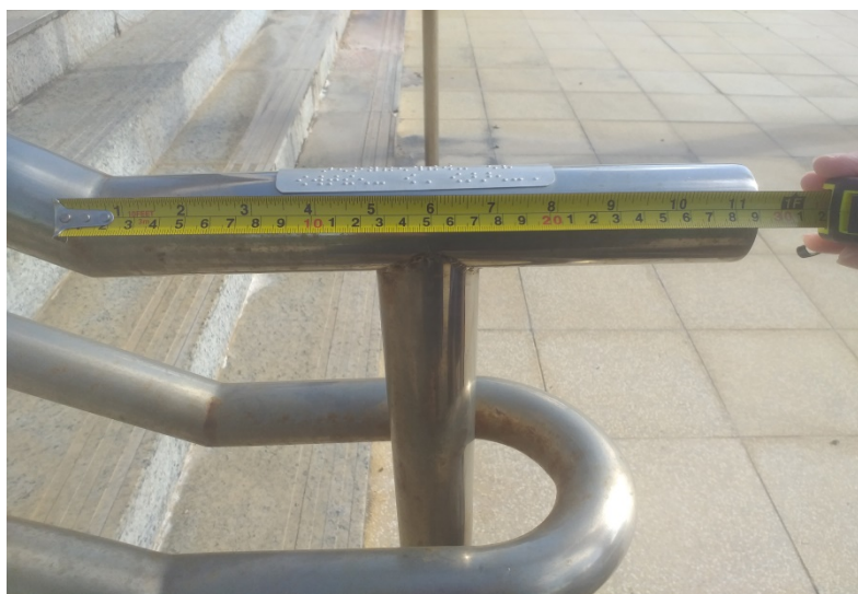
Figura 57 - Prolongamento do Corrimão
