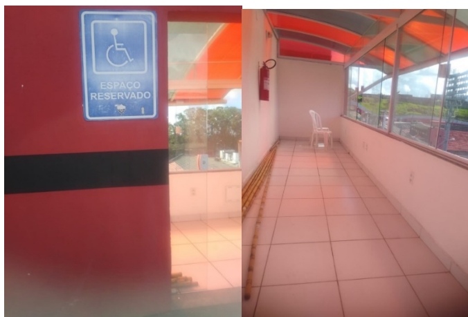
Figura 191 - Área reservada a torcedor PcD no estádio
