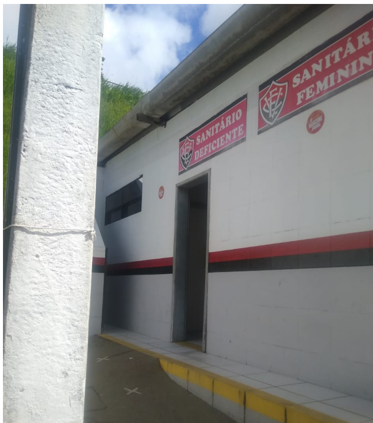
Figura 198 - Terceiro banheiro reservado a PcD: “sanitário deficiente”
