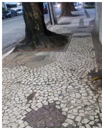
Figura 76 - Calçada externa oeste
