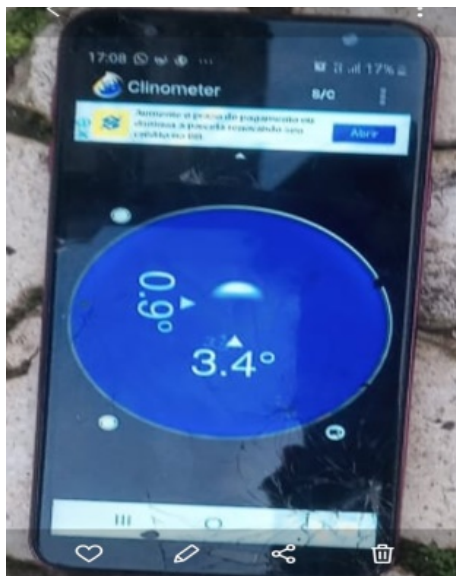
Figura 86 - Inclinação do piso no jardim
