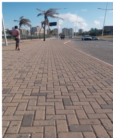
Figura 42 - Calçada de piso intertravado
