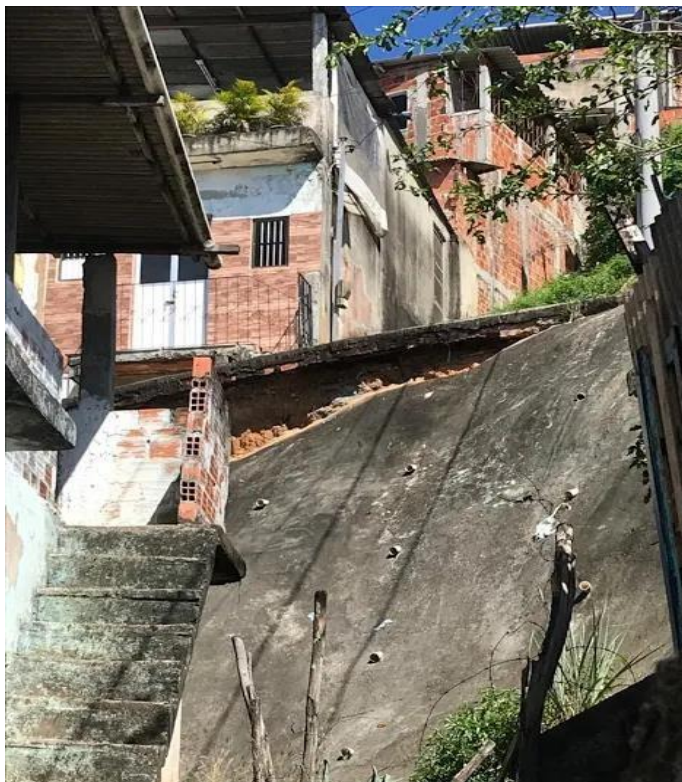
Figura 4 – Obras de contenções realizadas no Alto do Bom Viver
