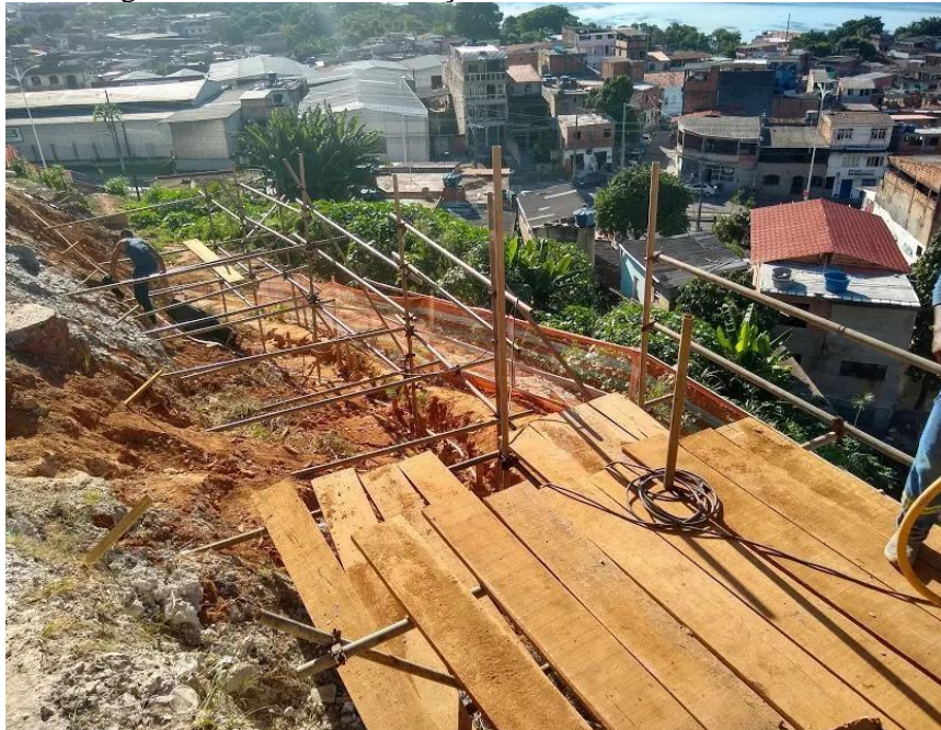
Figura 7 – Obras de contenção de encostas em Maria Izabel
