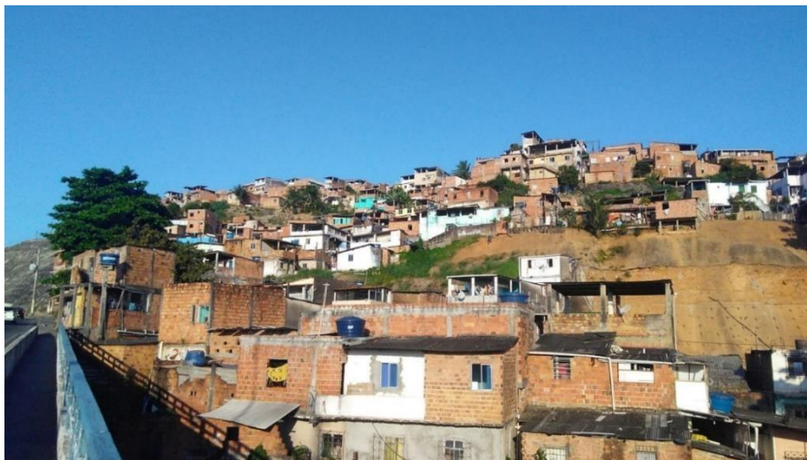
Figura 8 e 9 – Contenção de encostas (Alto do Bom Viver)
